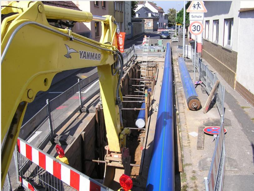
**Bild 1:** Relining mit Rohren aus PE 100-RC
