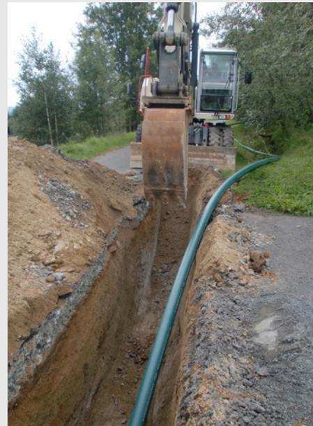
**Bild 2:** Rohre aus PE 100-RC für die sandbettlose Verlegung
