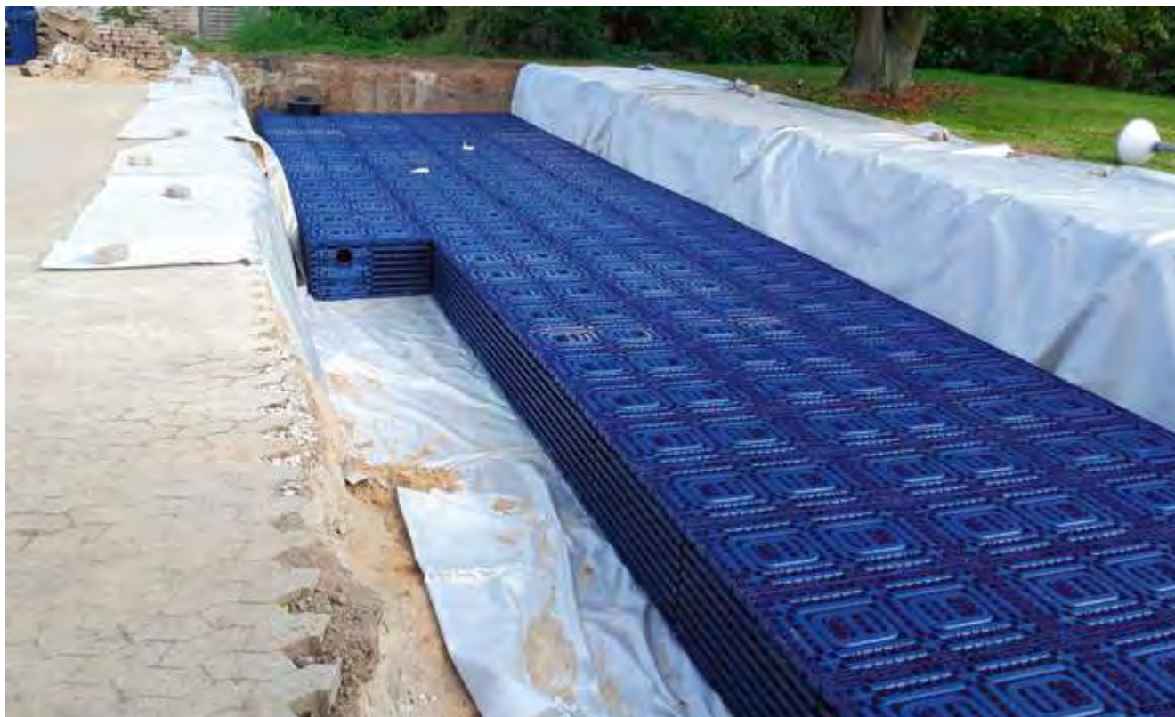
Q-Bic Plus Einbau bei engen Platzverhältnissen
