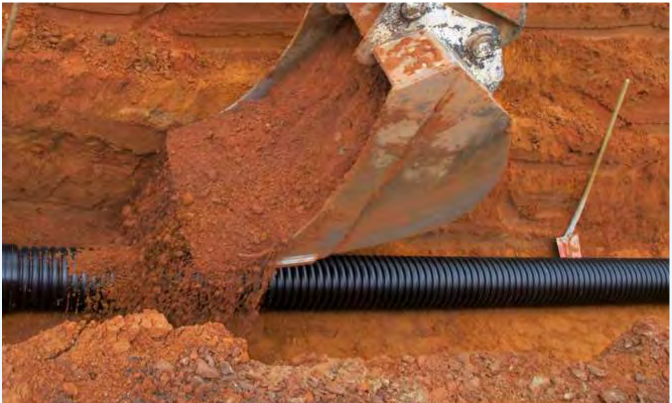
Einfache Lagesicherung durch Sandkegelaufschüttung
