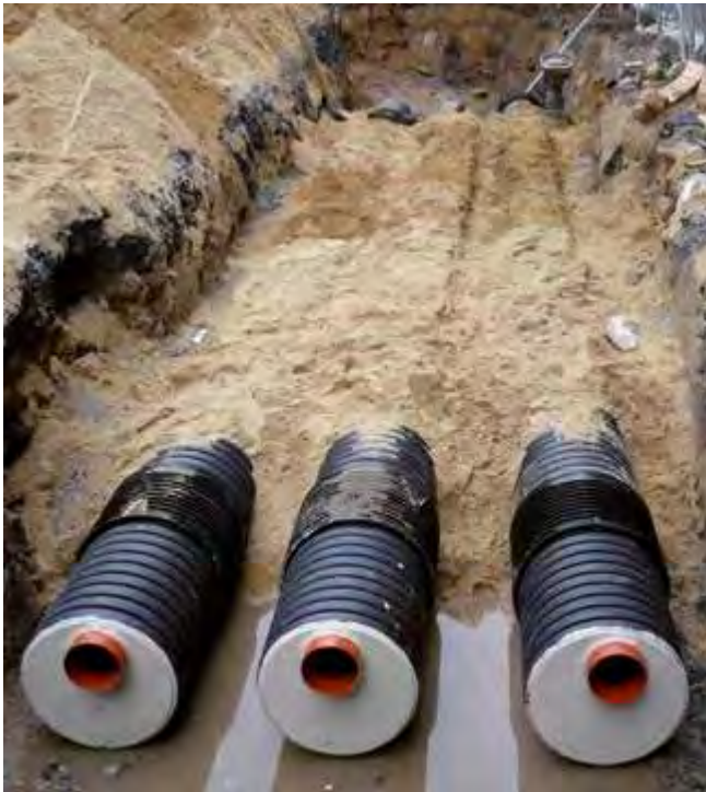
Sonderanwendung als Regenwasserstauraumkanal
