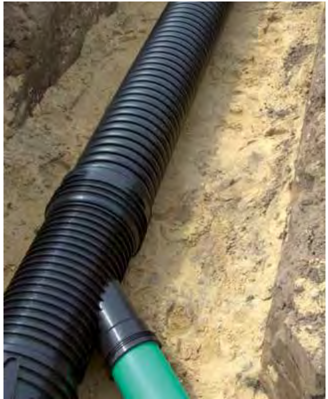
Schneller Anschluss von KG und KG 2000 über Abzweige
