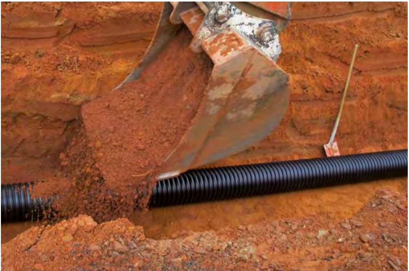
Einfache Lagesicherung durch Sandkegelaufschüttung
