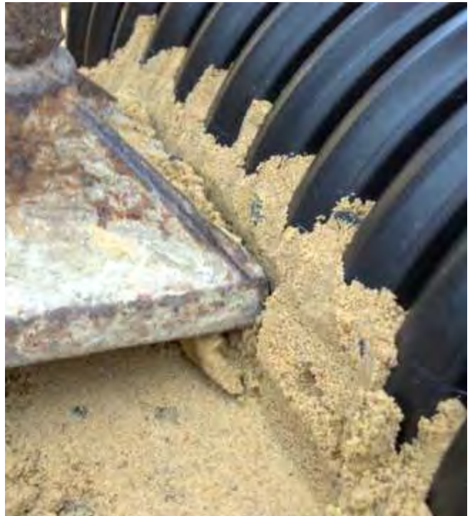
Gute Verankerung im Boden durch das Wellenprofil
