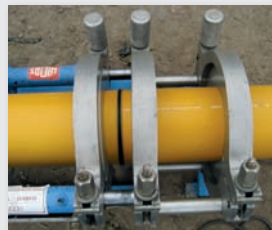
Bild 9: Heizelement-Stumpfschweißen
