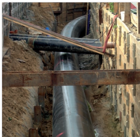
Bild 13: Einbau im Graben mit Sandbett
