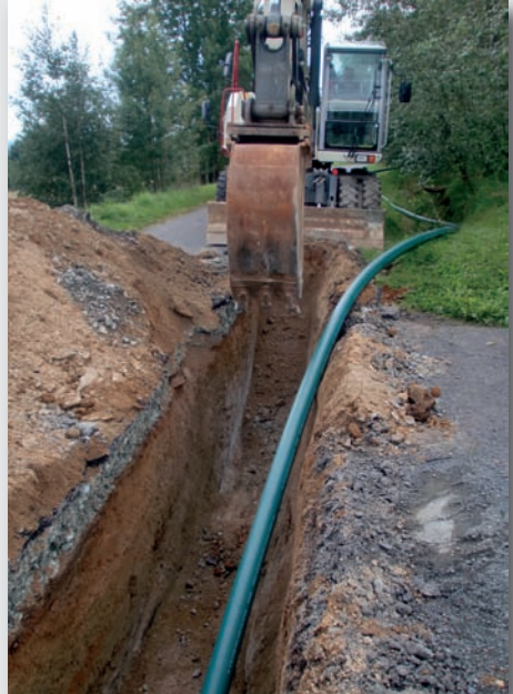
Einbau eines PE 100 RC-Druckrohres im offenen Graben
