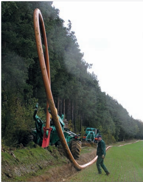
Bild 18: Pflugverfahren
