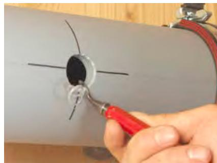
Fassen Sie die Bohrung an. Dadurch lässt sich die Heizbuchse im nächsten Arbeitsschritt leichter in die Bohrung einführen.
