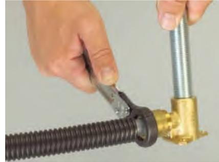
Halten Sie den Klemmverbinder mit einem Rohrnippel, während Sie die Überwurfmutter mit dem passenden Ratschenschlüssel (d16 = SW 24, d20 = SW 27) fest anziehen. Der Klemmring ist danach bei der Dimension 16 bis 2 mm sichtbar.
