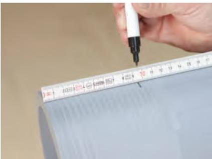
Zeichnen Sie die Einsteck- und Fügetiefe entsprechend des Rohres an. Achten Sie darauf, dass der Markierungsstrich während dem Schweißen sichtbar bleibt.
