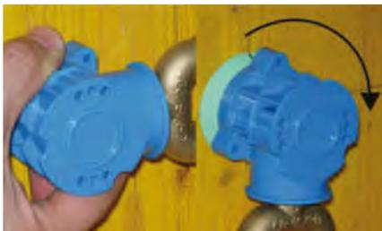
Schrauben Sie den Armaturenanschluss auf den Befestigungsteller.
