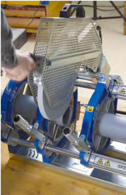
Das Schweissgerät beginnt zu piepsen. Nach 10 Sekunden nehmen Sie den Schweissspiegel aus der Schweissvorrichtung und stellen ihn zurück in die dafür vorgesehene Haltevorrichtung.
