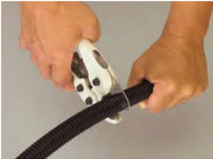
Schneiden Sie das Leitungs- und Schutzrohr mit der Rohrschere ab.
