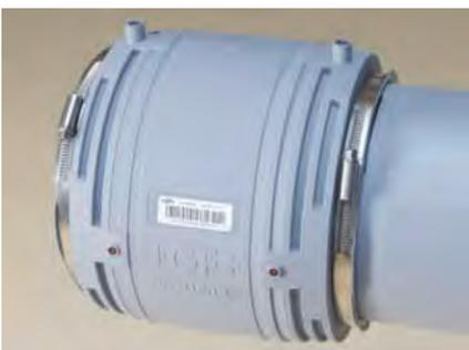
Schieben Sie die Muffe auf das Rohr.
