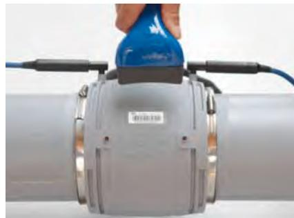
Scannen Sie die Codierung mit Barcodeleser ein. Dadurch werden die Schweißdaten an das Schweißgerät übermittelt.
