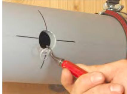
Fassen Sie die Bohrung um 3–4 mm an. Dadurch lässt sich die Heizbuchse im nächsten Arbeitsschritt leichter in die Bohrung einführen.
