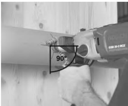
Durchbohren Sie die Rohrwand mit einem Bohrer. Benutzen Sie eine drehzahl-geregelte Bohrmaschine mit 300–350 U/Min.
