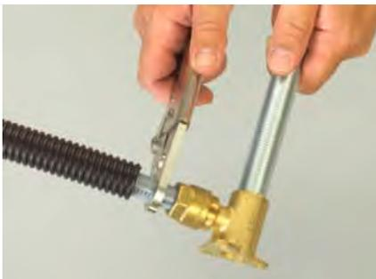
Stecken Sie das Leitungsröhr bis zur Markierung der Einstecktiefe mit der Montagezange oder von Hand in den Klemmverbinder ein.
