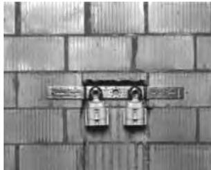
Anschlussgehäuse auf den Distanzhalter aufschrauben und in Mauer-
