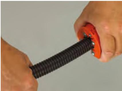
Verwenden Sie zum Kürzen des Schutzrohrs ausschliesslich den Schutzrohrschneider, um das Leitungsrohr nicht zu beschädigen.
