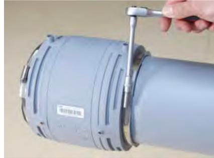
Fixieren Sie die Muffe mit dem Spannbänder auf dem Rohr.
