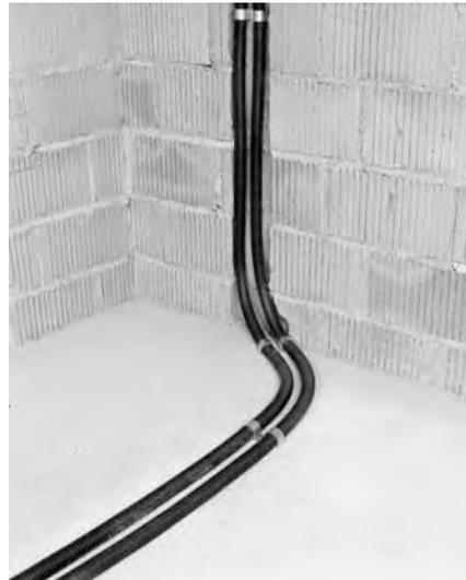
Stellen Sie beim Übergang von der Fussbodenebene in die Wandebene bzw. bei Übergängen in den Wandebenen sicher, dass der Mindestbiegeradius eingehalten werden kann.
