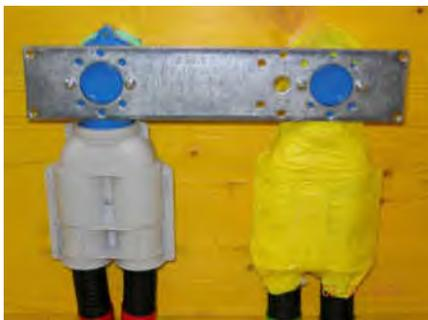
Befestigung mit angenagelten Befestigungstellern aus Kunststoff und Distanzhalter aus Metall.
