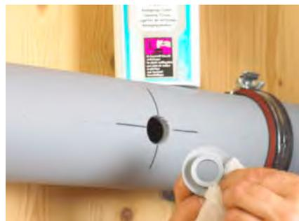
Reinigen Sie den Aufschweiss-Sattel mit Tangit KS-Reiniger, Art.-Nr. 799 298 023. Entfernen Sie die Reinigungsflüssigkeit restlos mit dem Reinigungspapier. Achten Sie darauf, dass Sattel- und Rohrdimension übereinstimmen.
