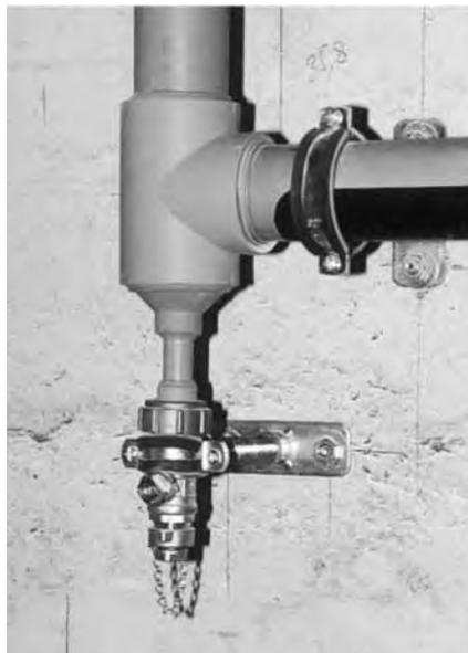
**Befestigen Sie Entleerventile immer direkt mit einer Rohrschelle!**
