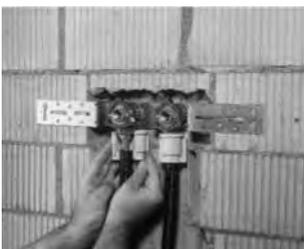
Schutzrohrhalter öffnen, Leitungsrohr einstecken, Klemmverbindung montieren, Schutzrohrhalter einschnappen.
