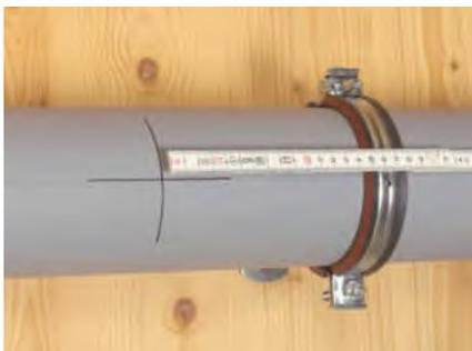
Setzen Sie ca. 15 bis 20 cm neben der Bohrstelle eine Rohrschelle, damit das Rohr sich während der Montage nicht ausbiegen kann.
