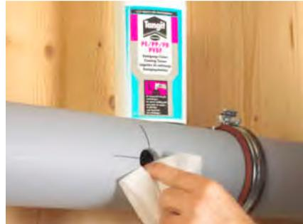
Reinigen Sie das Rohr und die Bohrung mit Tangit KS-Reiniger, Art.-Nr. 799 298 023. Entfernen Sie die Reinigungsflüssigkeit restlos mit dem Reinigungspapier.
