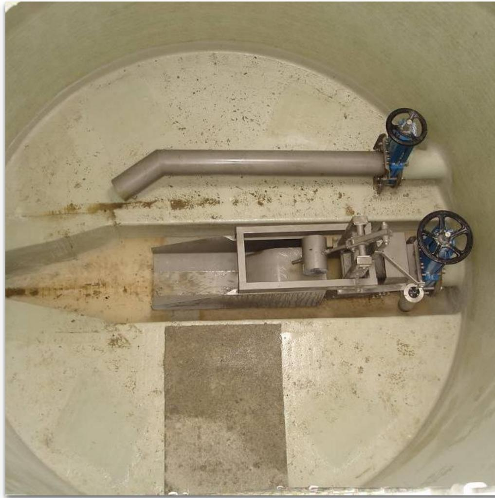
Waagedrossel - Halbtrockenaufstellung
