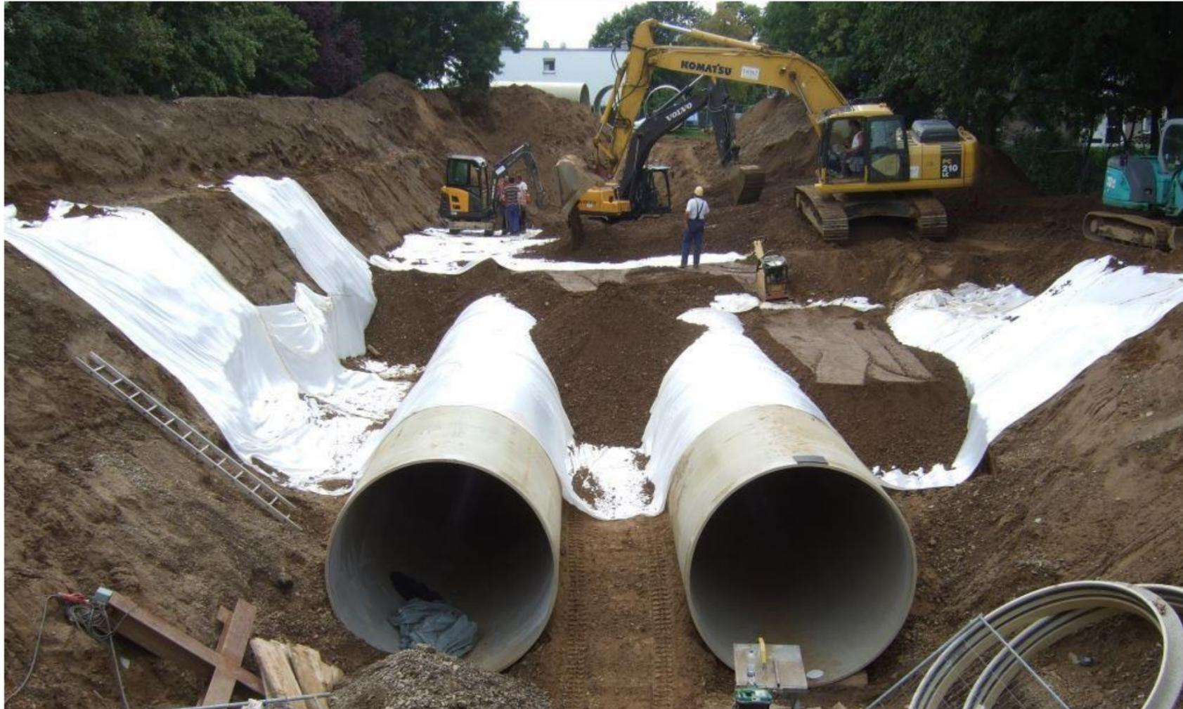
Auftriebssicherung mit einem zugfesten Geokomposit
