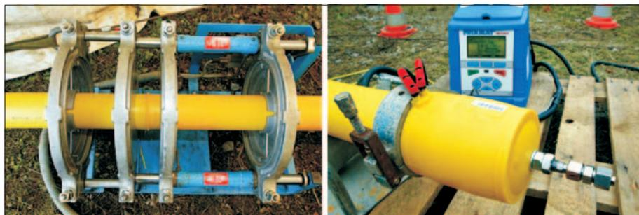
**Bild 8:** Heizelement-Stumpfschweißen und Elektroschweißen von PA 12 mit Standard-Geräten für die PE-Rohr-Installation
