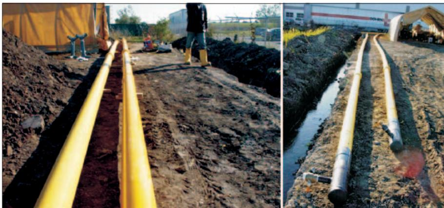
**Bild 3:** PA 12-Testinstallationen (17 bar (Luft) 6" SDR 11) bei GTI in den USA
