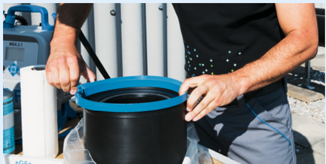
Stecken Sie die Montagehilfe auf das Fitting. Dehnen Sie damit die Dichtlippe durch Zusammendrücken der Griffe.
