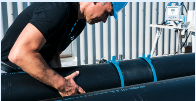
Schieben Sie die Rohrenden bis zur Markierung in das Fitting. Ziehen Sie die Montagehilfe danach wieder ab.
