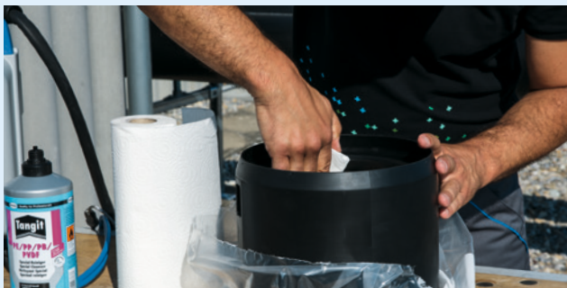
Reinigen Sie die Schweissfläche des Fittings und der Rohre mit einem sauberen Tuch.
