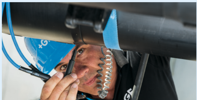
Verbinden Sie die Schweisskabel mit den Schweisskontakten des Fittings und schweissen Sie gemäss Anleitung.
