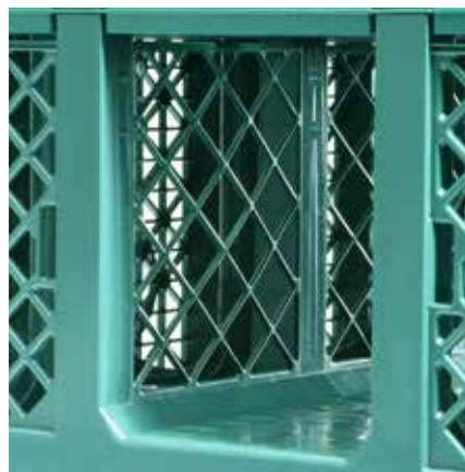
Große Öffnungen der Tunnelseitenwand ermöglichen Inspektion des gesamten Rigolenraumes
