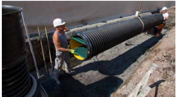
Einbau des Sedimentationsrohres
