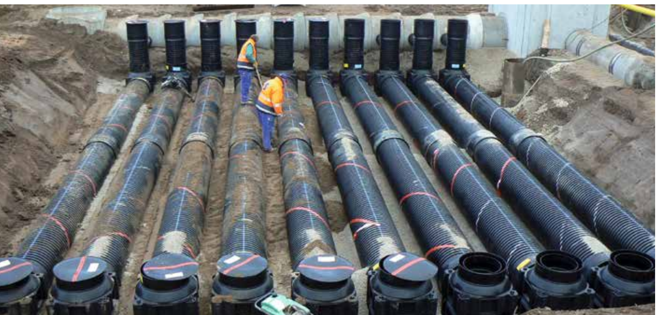
SediPipe (hier 10 x SediPipe 600/12) ersetzt ein Regenklärbecken in Betonbauweise
