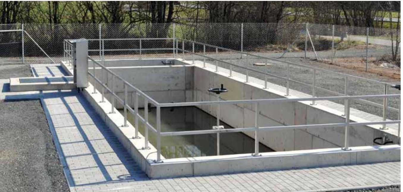
Regenklärbecken in Betonbauweise
