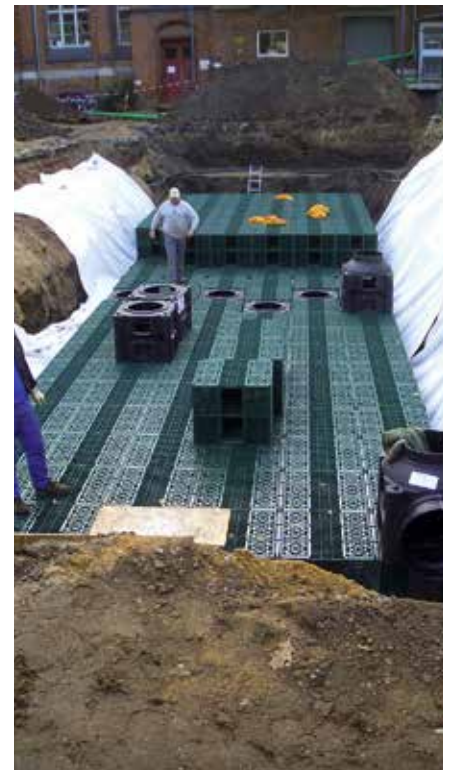
Mittige Anordnung der QuadroControl Schächte
