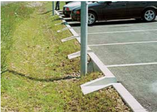
Muldenrigolen-Versickerung zur Parkplatz-Entwässerung. Die Beschickung erfolgt über Rinnen
