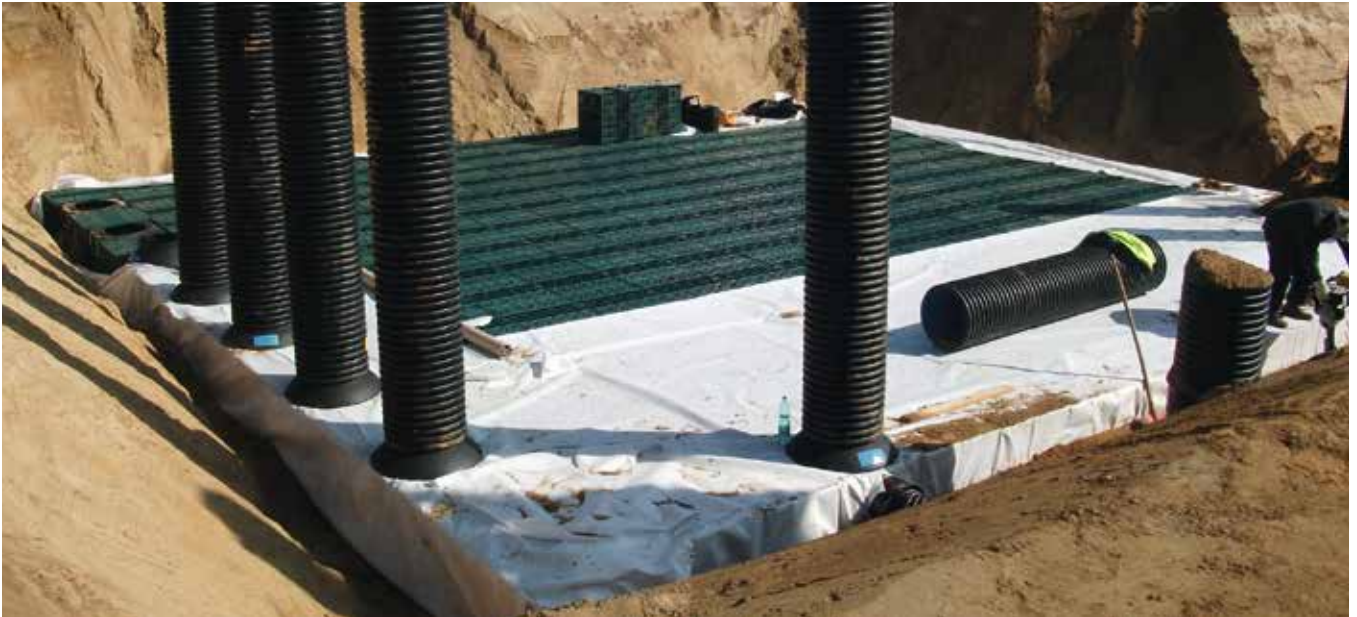
Versickerungsrigole: Einlagige Rigofill-Füllkörperrigole mit sternförmig angeordneten QuadroControl Schächten
