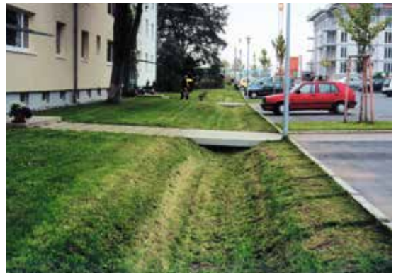
Muldenrigolen-Versickerung in einem Erschließungsgebiet
