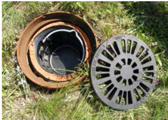
Muldenüberlauf: Filter-Set D A 400 und Einlaufrost
