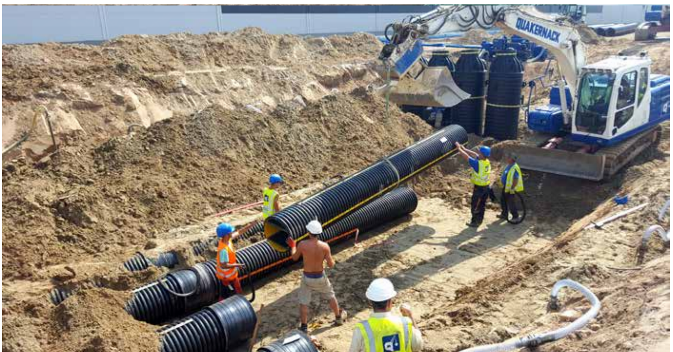
Montage des Sedimentationsrohres
