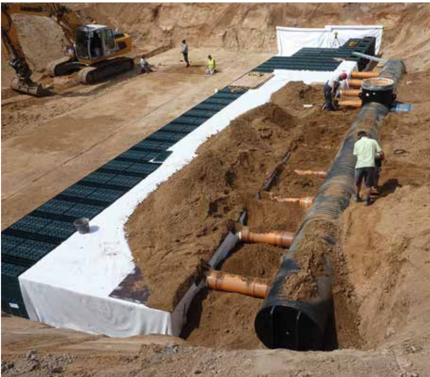
Zweilagige Rigofill-Füllkörperrigole mit Zulaufverteilung
