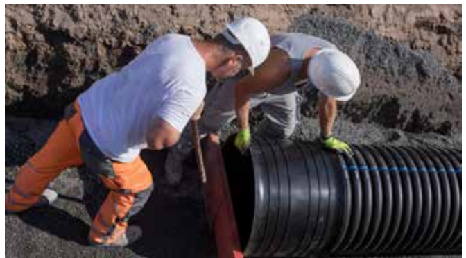
Montage des Sedimentationsrohres
