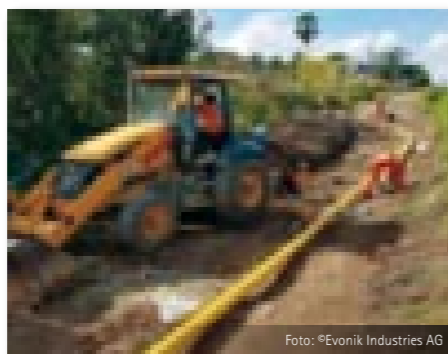
Druckrohrleitungen der Dimension Da 160 SDR 11 aus Polyamid (PA-U 12)
