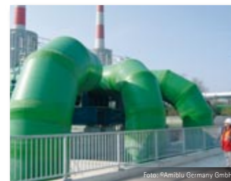
Kühlwasserleitung aus GFK in einem Gaskraftwerk
