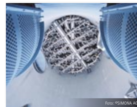
Düsenlanzen und Siebkörbe aus PP-H einer Rauchgasentschwefelungsanlage in einem Kohlekraftwerk
