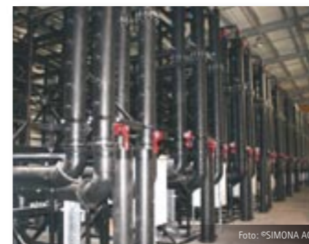
Entsalzungsanlage mit Rohren und Formteilen aus PE100
