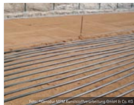
Installation des Wärmetauschers
