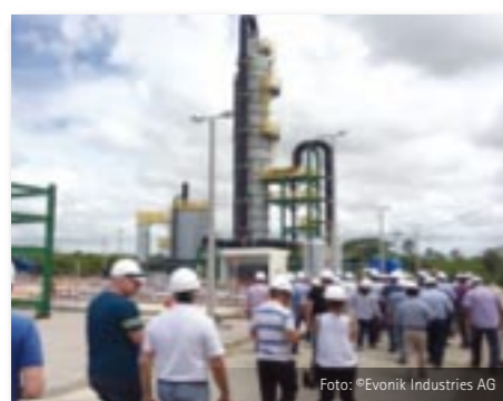
Anlage zur Umwandlung von Biogas aus Siedlungsabfällen in Biomethan
