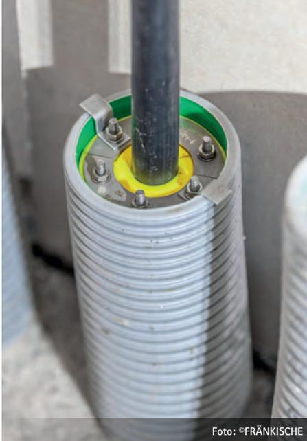
Bild 3: Die Innendichtung Kabu-IN DD von FRÄNKISCHE mit Segmentringtechnik sichert das Kabel passend für den jeweiligen Durchmesser gas- und druckwasserdicht ab.
