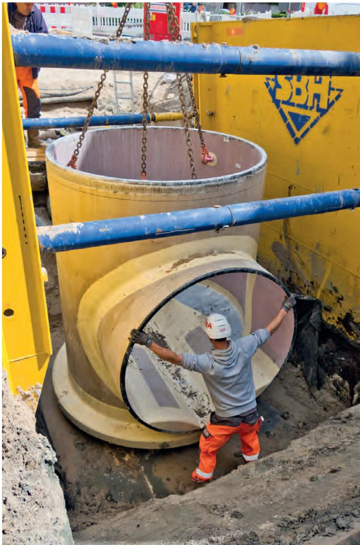
Bild 7: Durch ihr relativ leichtes Gewicht können für das Setzen der GFK-Schächte mit den vorhandenen Baggern verbaut werden.
