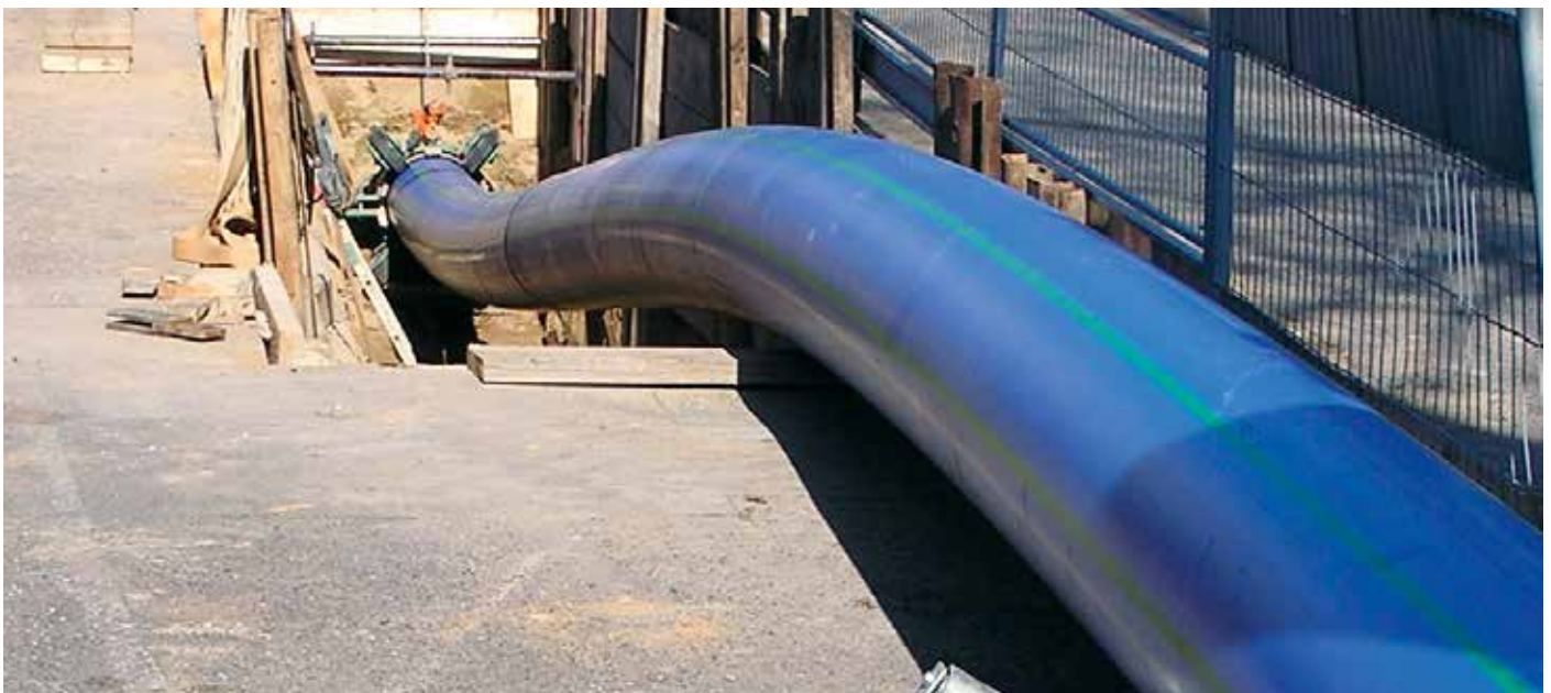
Langlebigkeit, Sicherheit, Kosten- und Umweltfreundlichkeit sind die entscheidenden Kriterien für die Wahl von PE 100-RC Rohren für Trinkwassersysteme. Die einzigartige Rissbeständigkeit und die hohe Einsatzvielfalt überzeugen im Vergleich der Rohrsysteme. Foto: Simona AG
