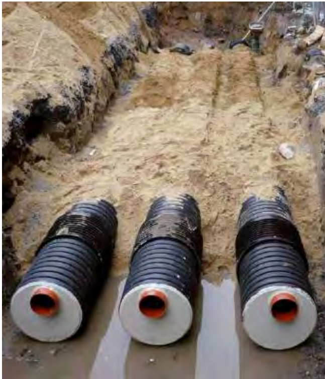
Sonderanwendung als Regenwasserstauraumkanal
