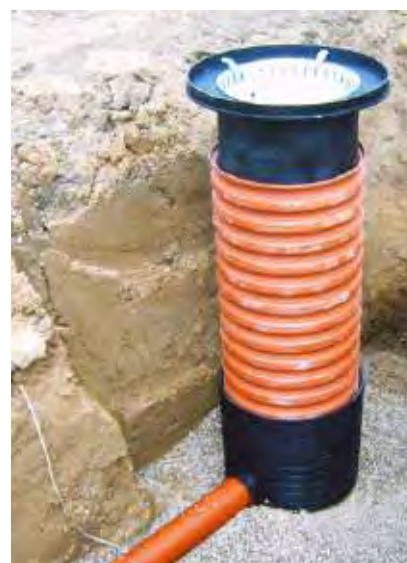
Als Kanalschacht mit Teleskopadapter
