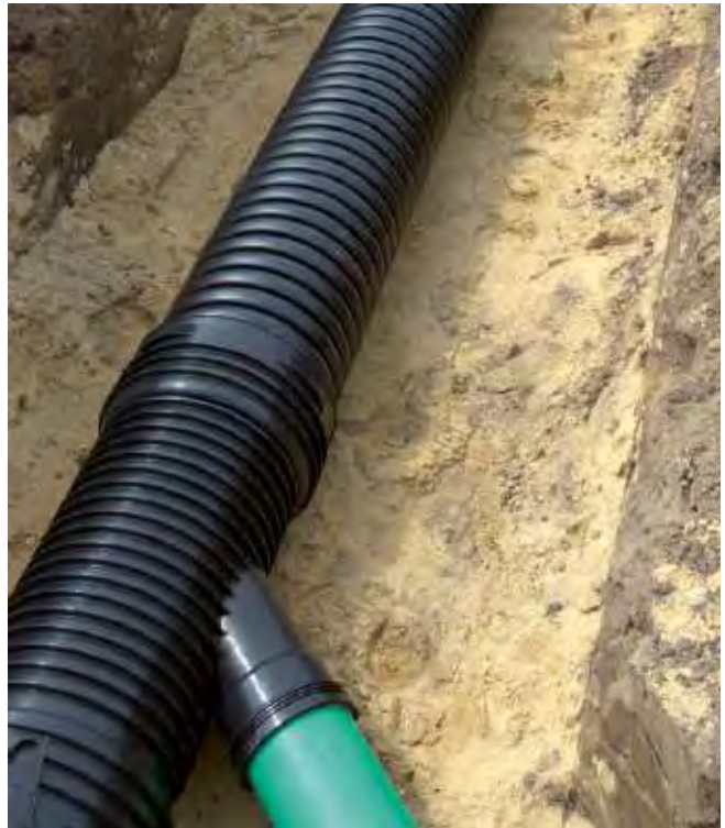
Schneller Anschluss von KG und KG 2000 über Abzweige
