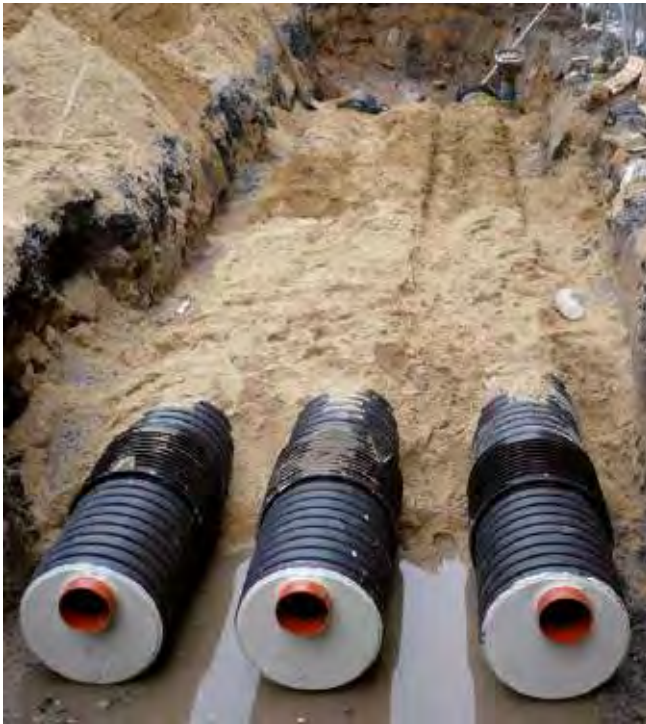
Sonderanwendung als Regenwasserstauraumkanal
