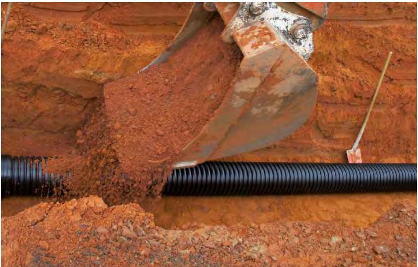
Einfache Lagesicherung durch Sandkegelaufschüttung
