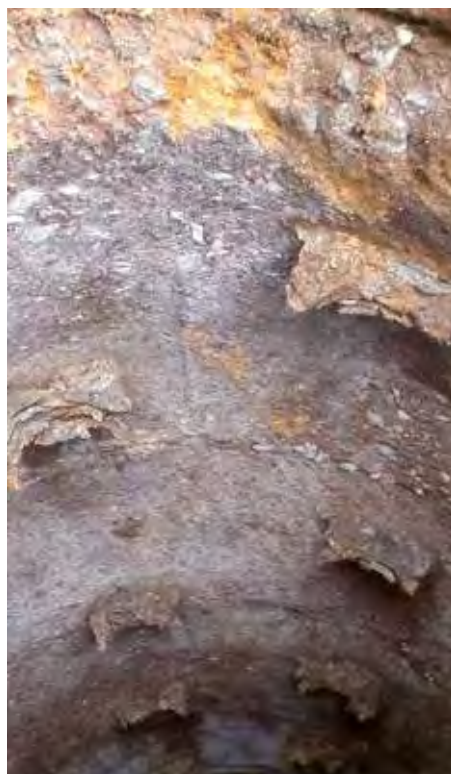
Biogene Schwefelsäurekorrosion:
