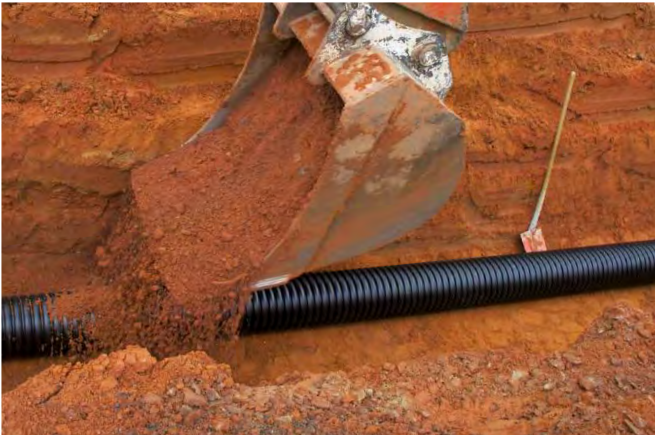
Einfache Lagesicherung durch Sandkegelaufschüttung
