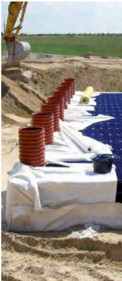
Als Rigolen-Inspektionsschacht
