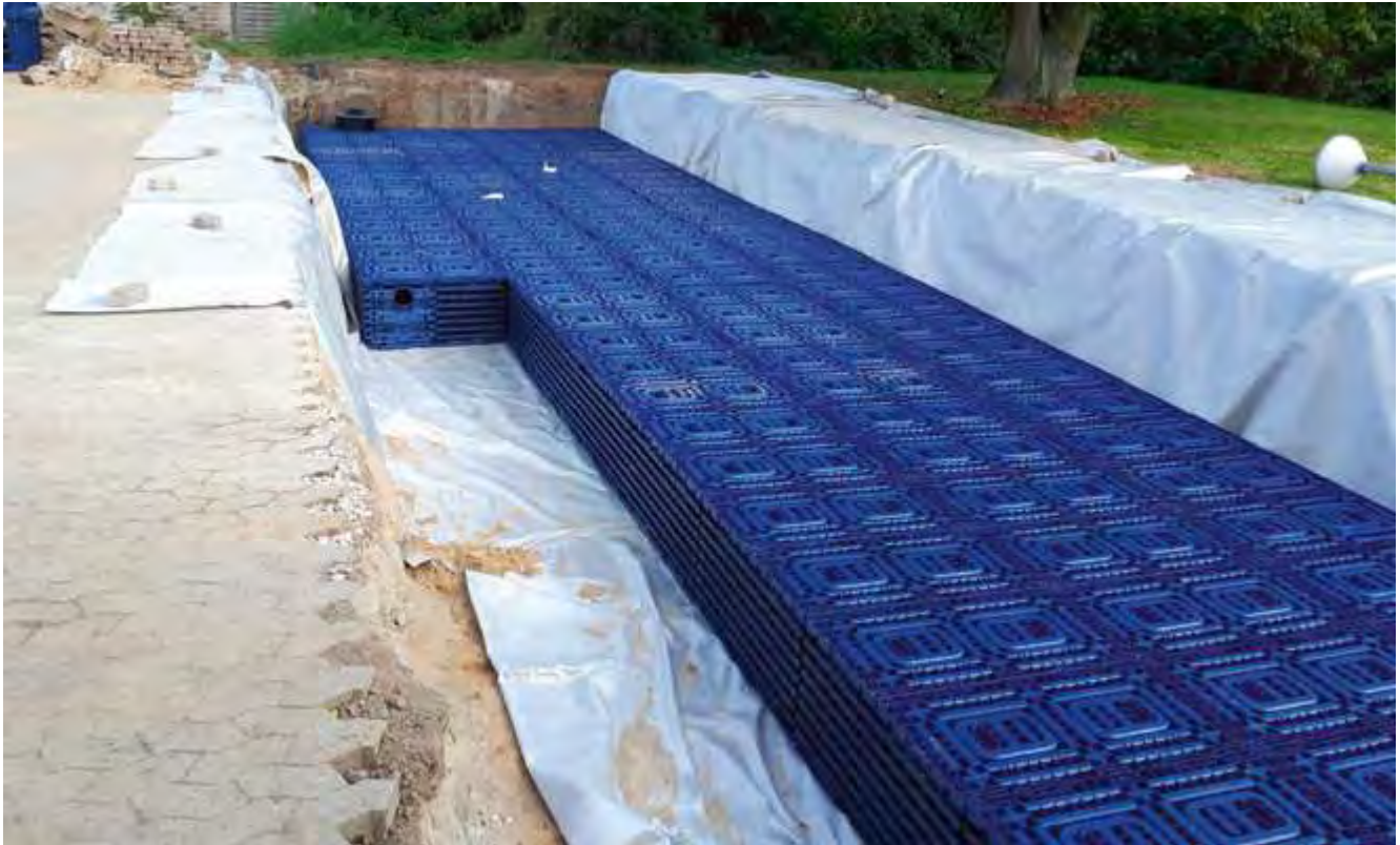
Q-Bic Plus Einbau bei engen Platzverhältnissen
