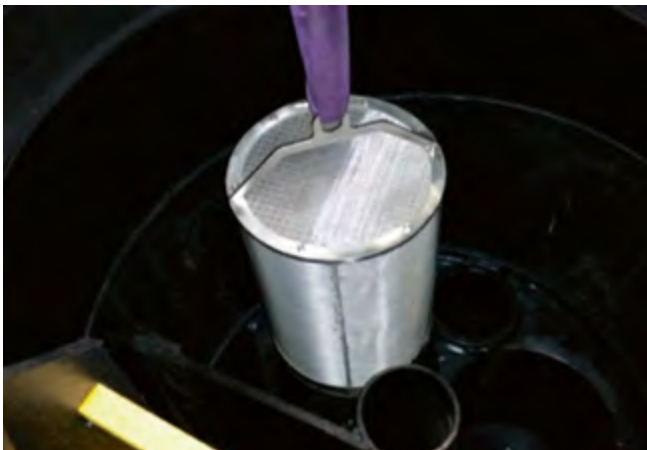
Herausheben der Kartusche
