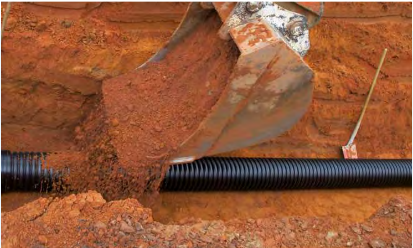
Einfache Lagesicherung durch Sandkegelaufschüttung
