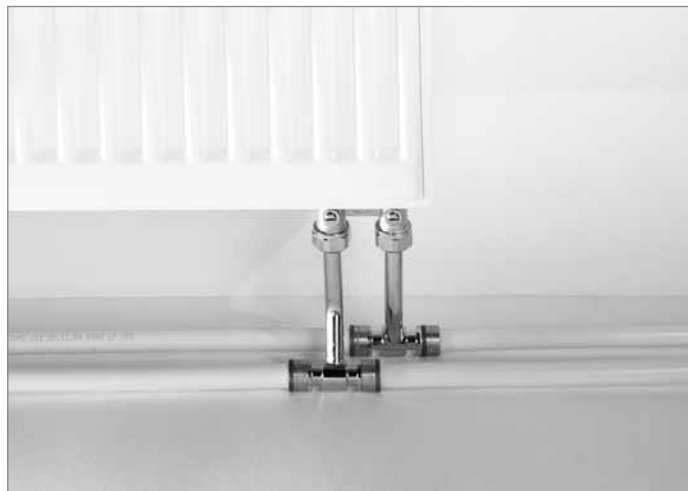
Heizkörperanschluss mit HK-Montage-T-Stück
