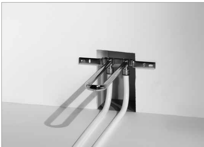
Heizkörperanschluss mit HK-Montagegarnitur – bereit zum Abdrücken
