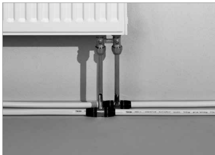
Heizkörperanschluss mit HK-Montage T-Stück
