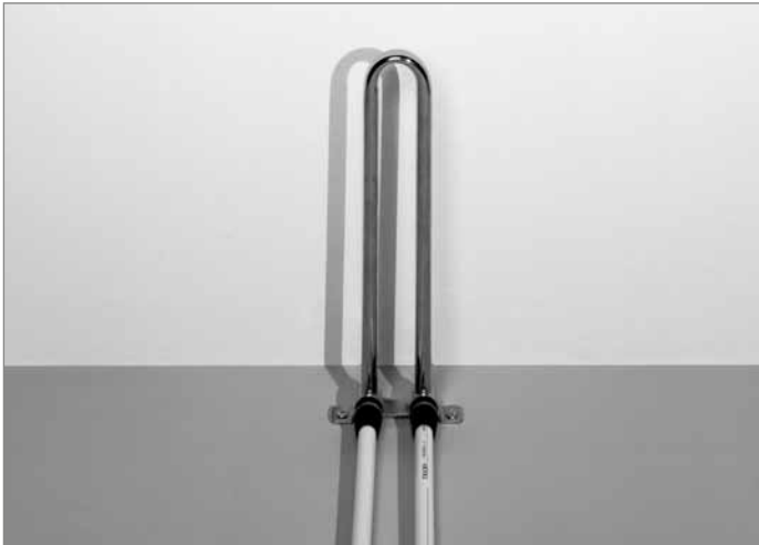
Heizkörperanschluss mit HK-Montagegarnitur, Bodenmontage – bereit zum Abdrücken
