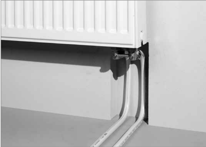
Heizkörperanschluss aus der Wand
