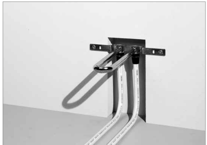
Heizkörperanschluss mit HK-Montagegarnitur, Wandmontage – bereit zum Abdrücken
