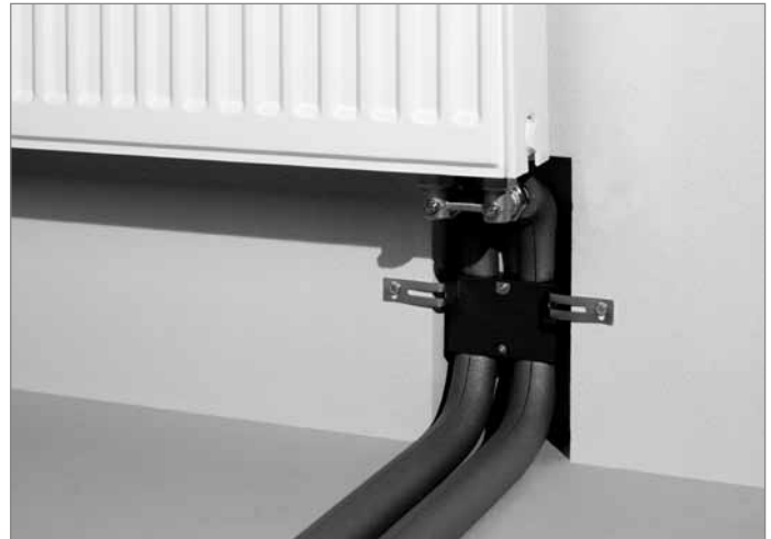
Heizkörperanschluss mit Montagemodul – an den Hahnblock angeschlossen
