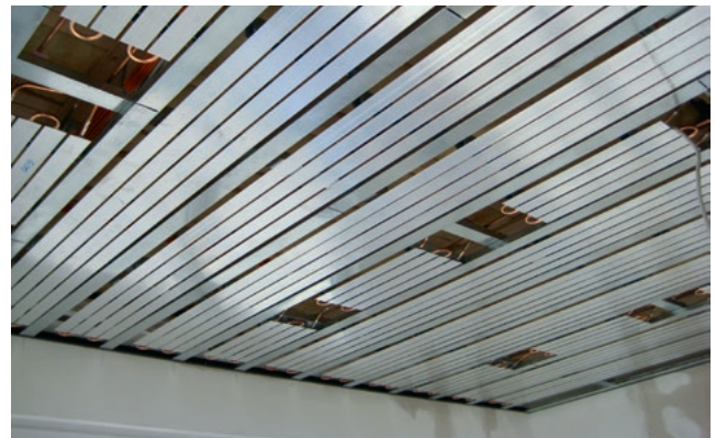
Decke mit Heiz-/Kühldeckenmodulen KA-4
