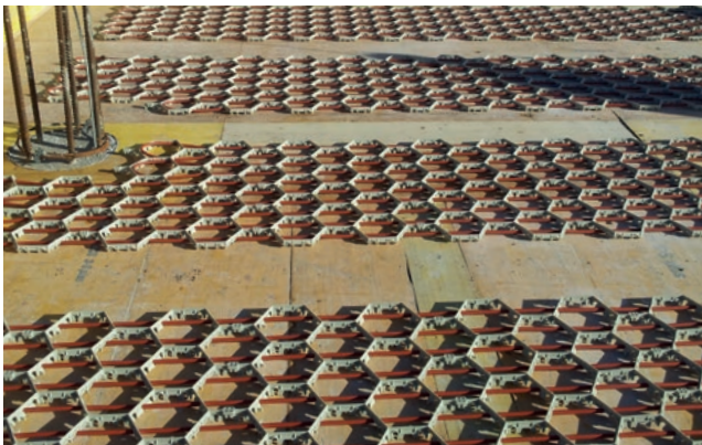
Deckenbelegung mit Wavin CW-90-Registern.
