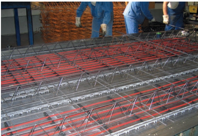
Herstellung eines Betonfertigteils mit integriertem CW-90.
