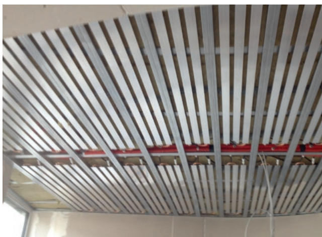
Heiz-/Kühldeckenmodule KA-3
