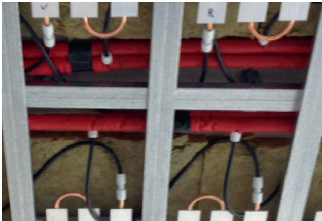
CU/AL Modul KA-3 mit wechselseitigen Tichelmann Anschluß
