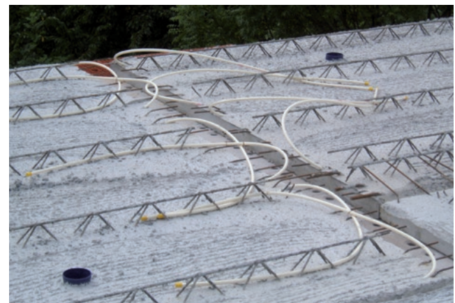
Wasserseitiger Anschluss von CW-90-Registern mit Metalverbundrohr.
