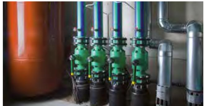
Die Steig- und Verteilungsleitungen für die Heizungsversorgung sollten in aquatherm blue pipe Verbundrohren geplant und ausgeführt werden.
