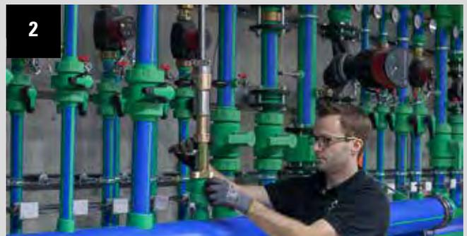
Montage des Anbohrwerkzeuges auf das Aufschweißsattelset
