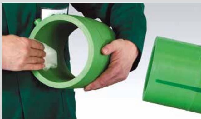
Reinigen der E-Muffen Innenfläche mit einem flusenfreien Tuch oder Papier. **Unmittelbar vor der Schweißung** erneut eventuell aufgetretene Feuchtigkeit entfernen.
