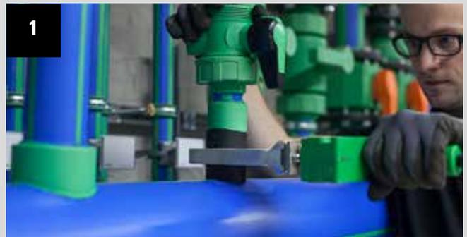
Aufschweißen des Aufschweißsattelsets auf das Hauptrohr
