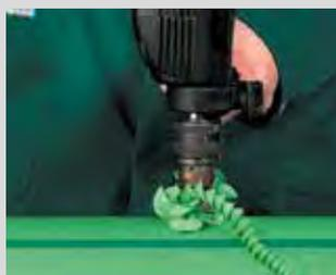
Durchbohren der Rohrwandung
