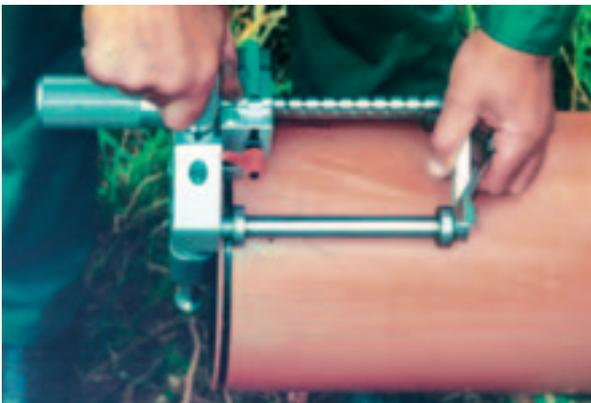
Vorbereitung der Rohrstirflächen für Heizelementstumpfschweißen (HS). Der Schutzmantel wird nur im Bereich der Schweißzone entfernt.
