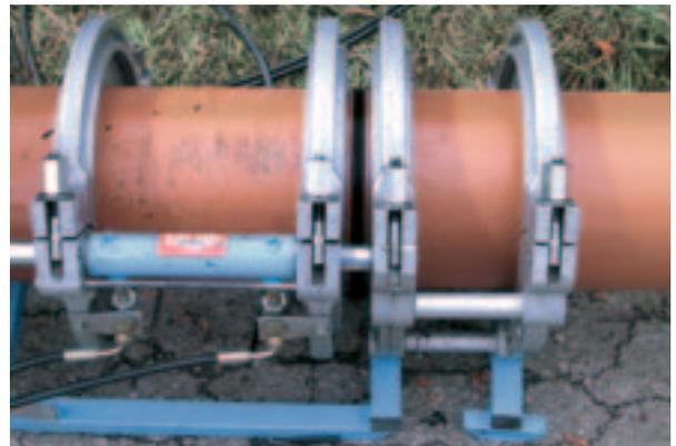
Verschweißen der Rohre im Heizelementstumpfschweißverfahren (HS). Die Verschweißung erfolgt gemäß DVS Richtlinie DVS 2207, Teil 1.
