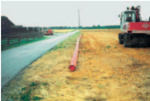
*Vorverschweißter Rohrstrang zum Einbringen in die Halterung*
