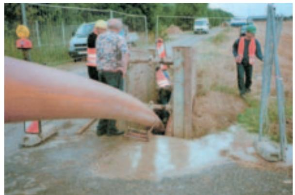
*Einzug der Rohre über eine Startgrube in die Haltung*
