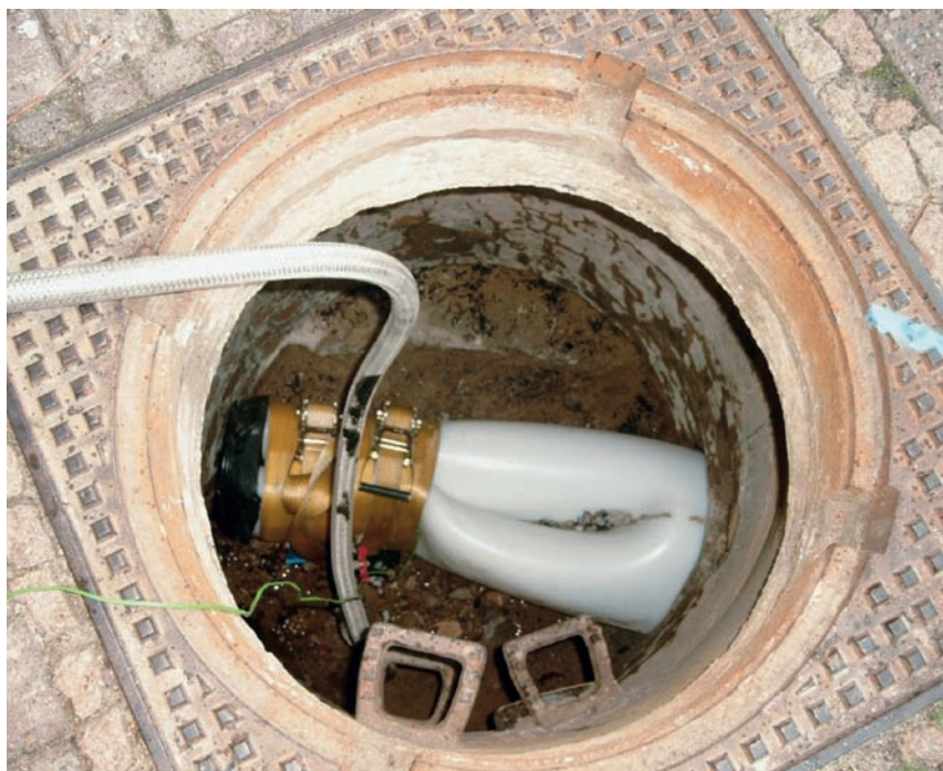
Abb. 7 Kanalsanierung mit Compact Pipe
