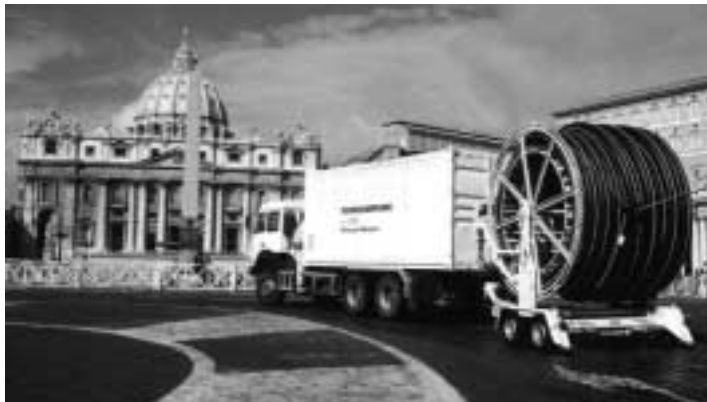
Bild 3: U-Liner-Sanierung in Rom, Vatikan-Stadt
