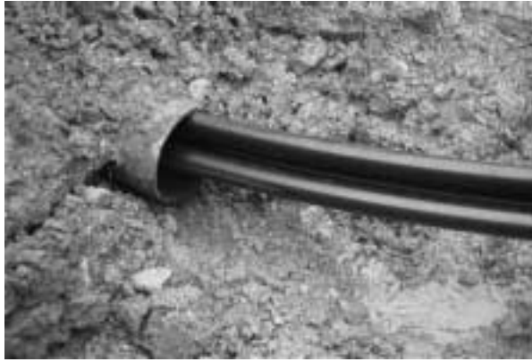
Bild 9: Der U-Liner läuft in das Altrohr
