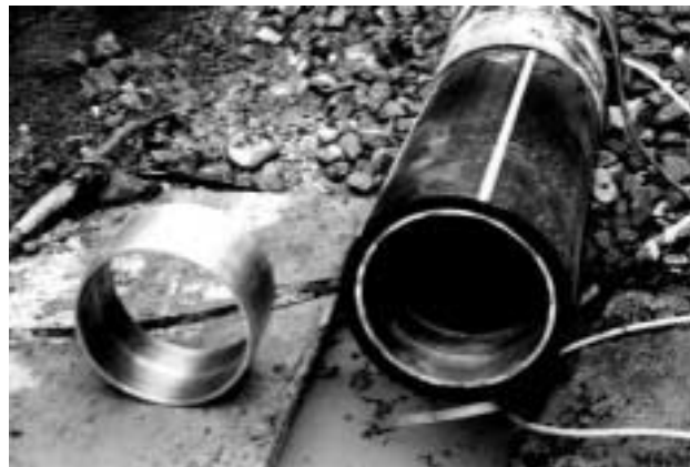
Bild 1: U-Liner, Querschnitt/Anlieferung Bild 2: U-Liner nach Installation
