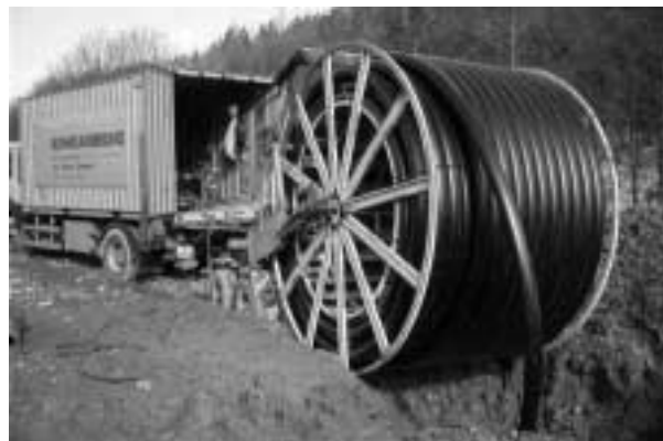
Bild 8: U-Liner im Rohrtrommelanhänger
