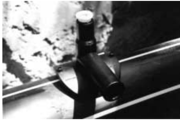
Bild 10: Anbindung von Hausanschlüssen durch einen Friatec-Top-loading-Sattel
