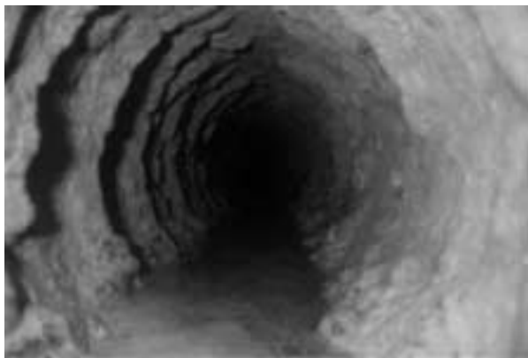
Bild 5: Altrohr vor der Reinigung
