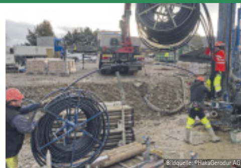
Infrastruktur (Erdwärmesonden)
