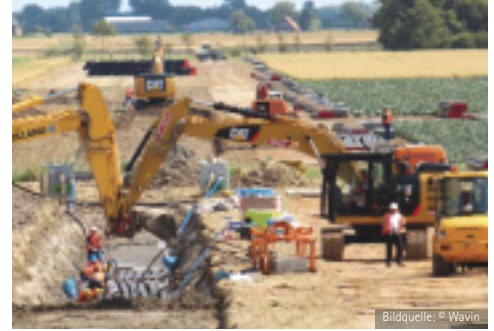
Schutzrohre für unterirdische Hochspannungskabel („Erdverkabelung“)
