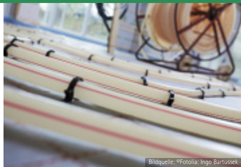
Gebäudetechnik (Fußboden- oder Niedrigtemperaturheizungen)
