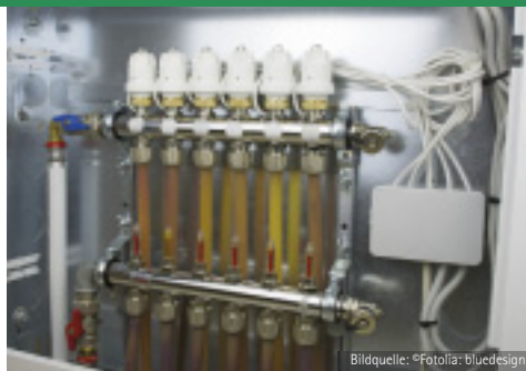
Gebäudetechnik (Erdwärmeverteiler)
