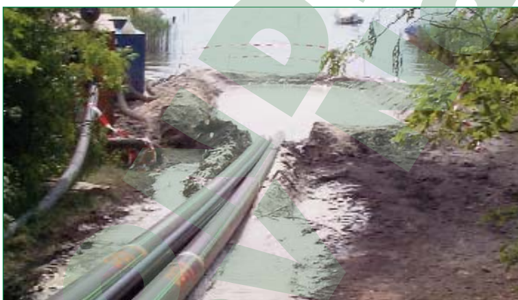
Bild 2: Rohreinlauf unter dem See im Spülbohrverfahren
