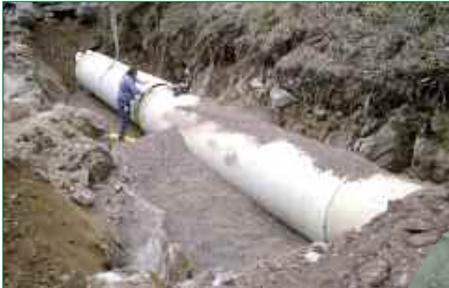
Bild 5: Installation eines 3 Meter-Rohres
