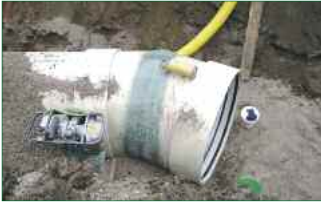
Bild 4: GFK-Segmentbogen mit REKA-Kupplung
