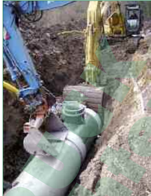
Bild 6: FLOWTITE-Formstück mit integrierter Wartungsöffnung
