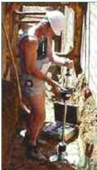
Bild 1: Messung der E_{vd} -Werte beim Ausheben des Leitungsgrabens
