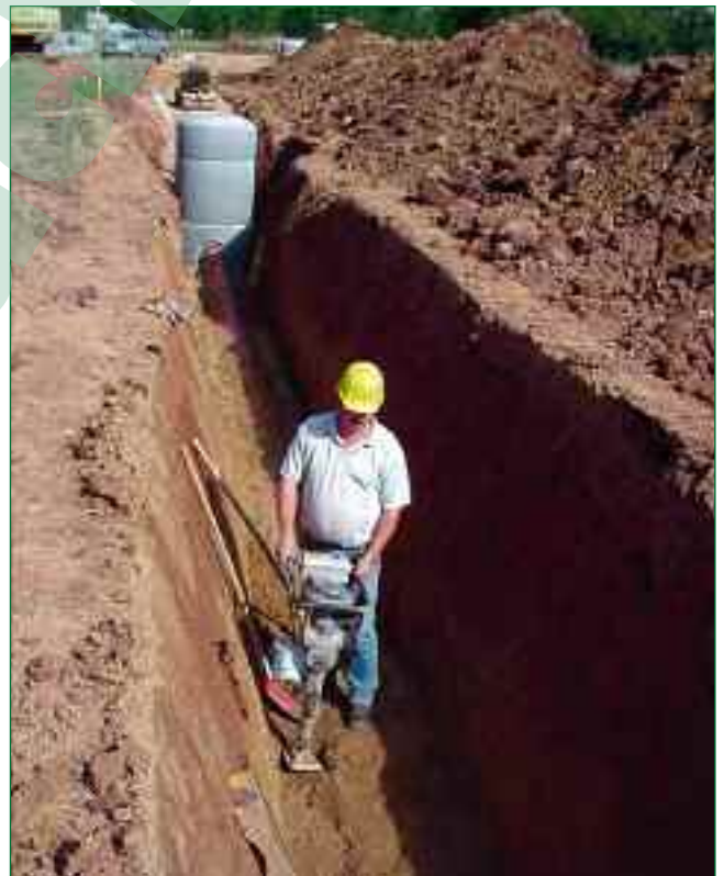
Bild 5: Rohrbettung und Umhüllung mit Feinkorn aus aufbereitetem Boden. Das Kunststoffrohr ist bis zum Scheitel gebettet und umhüllt. Das sehr verdichtungswillige Material stopft die Zwickel und erlaubt eine gute Verdichtung, ohne einen Auftriebseffekt auf das Rohr auszuüben.
