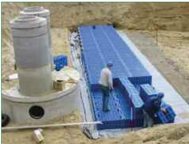
Bild 4: Einbau der Wavin ELWAbloc-Elemente aus PP
