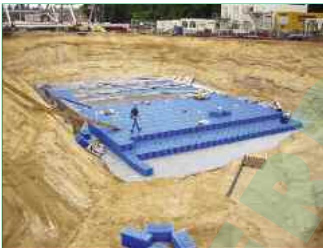
**Bild 2:** Grundlage der Sickerrigole aus Wavin ELWAbloc-Elementen
