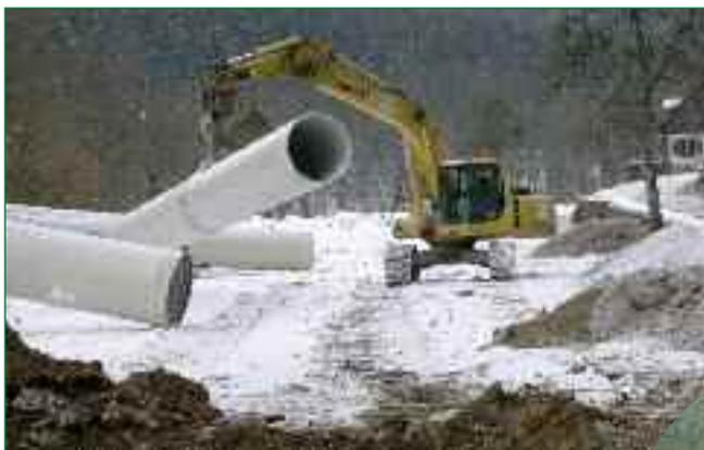
**Bild 1:** GFK-Rohrlager im spätwinterlichen Schwarzwald
