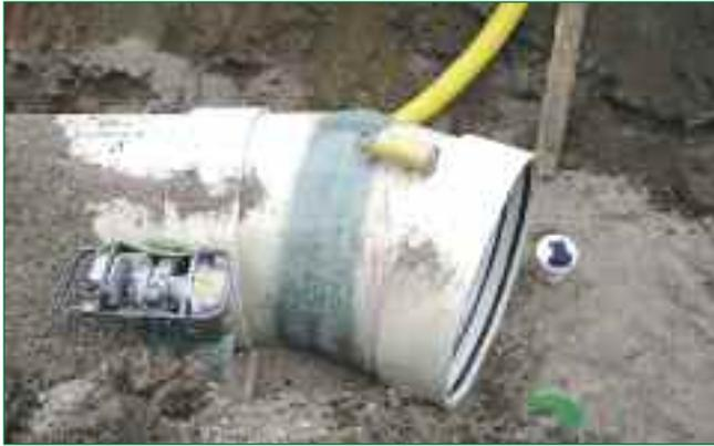
**Bild 4:** GFK-Segmentbogen mit REKA-Kupplung
