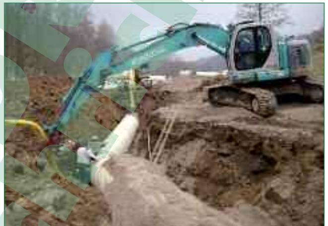
**Bild 7:** Durch diese GFK-Wickelrohrleitung DN 1200 des Systems FLOWTITE wird künftig das Kleinkraftwerk Schönmünzach mit Wasser versorgt
