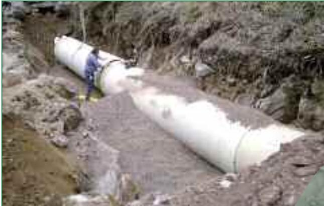
**Bild 5:** Installation eines 3 Meter-Rohres
