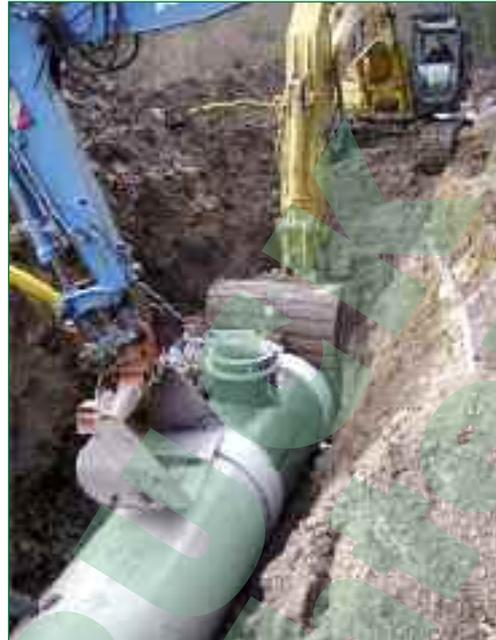
**Bild 6:** FLOWTITE-Formstück mit integrierter Wartungsöffnung
