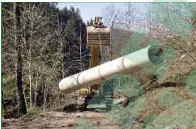
**Bild 2:** Im teilweise unwegsamem Gelände war das geringe Gewicht der GFK-Rohre von großem Vorteil
