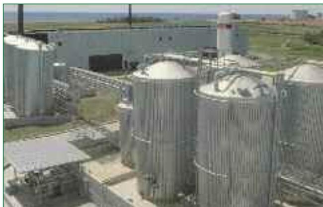
**Bild 2:** Behälter für die Mischung des PVC-Abfalls mit Lauge und Wasser
