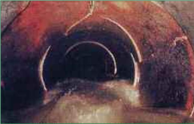
**Bild 1:** Ablagerungen in der Kanalisation [1]
