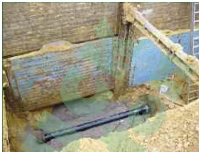
*Bild 2: Neue Freigefälleleitung in 6 m Tiefe*
