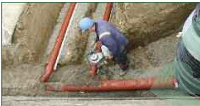
Bild 8: Rohrgraben mit auf Bettungskissen verlegten Rohren (Rödinghausen)
