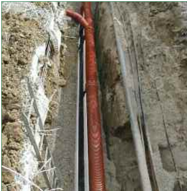
Bild 7: Huckepack verlegte Rohre in schmalen Rohrgraben (Rödinghausen)
