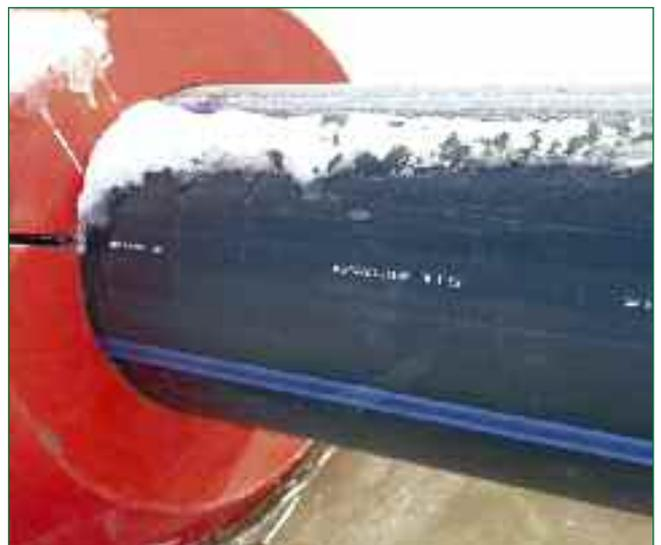
Bild 2: Detailansicht Rohr mit Schwimmer
