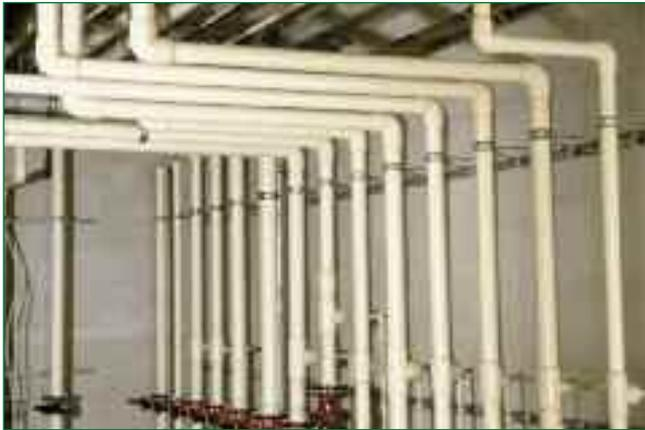
Bild 1: Das hygienische Trinkwassersystem: Zertifizierte PVC-C-Markenrohre sind für alle Trinkwässer geeignet und nach DVGW Arbeitsblatt W 270 geprüft
