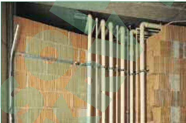
Bild 2: PVC-C-Rohre eignen sich auch hervorragend als Verteiler-, Keller- und Steigeleitungen
