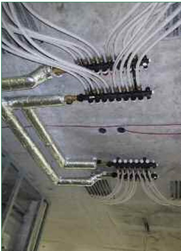
Bild 5: Verteileranschluss der Module unter der Decke
