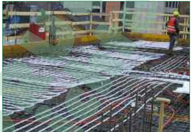
Bild 4: Verlegung der Module für die Betonkernaktivierung
