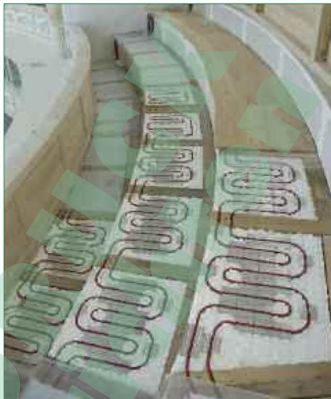
Bild 2: Fußbodenheizung auf den Emporen
