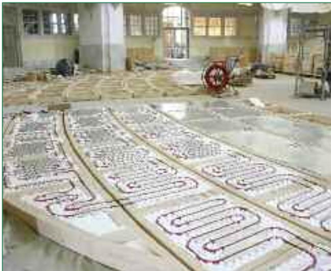
*Bild 3: Eingebaut wurde das Roth Trockenbausystem mit der TBS-Systemplatte PS 30 SE*
