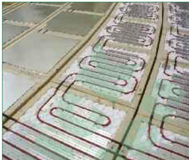
*Bild 5: Die Rohre wurden in omegaförmige Vertiefungen metallischer Wärmeleitlamellen der Systemplatten verlegt. Für eine gleichmäßige Wärmeverteilung an der Oberfläche wurden die Segmentflächen mit einem metallischen Wärmeleitblech abgedeckt*
