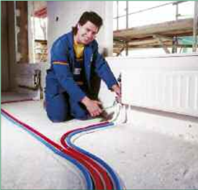
Bild 8: Heizkörperanbindung mit bereits vorgedämmten Kunststoffrohren
