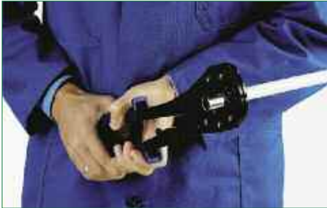
Bild 5: Ruck, zuck verbunden: Mehrschichtverbundrohr mit Pressfitting
