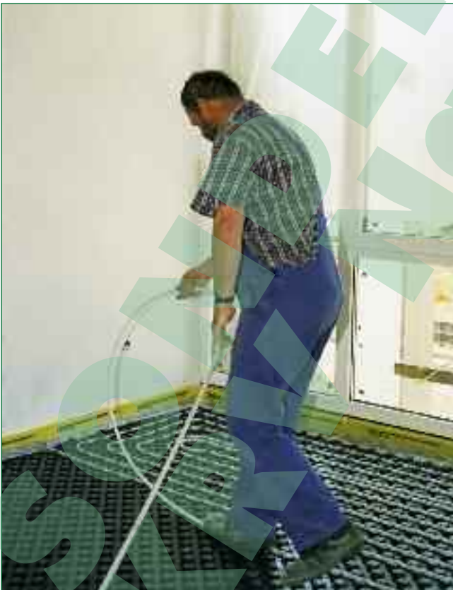
Bild 9: Rohrverlegung für eine Warmwasserfußbodenheizung
