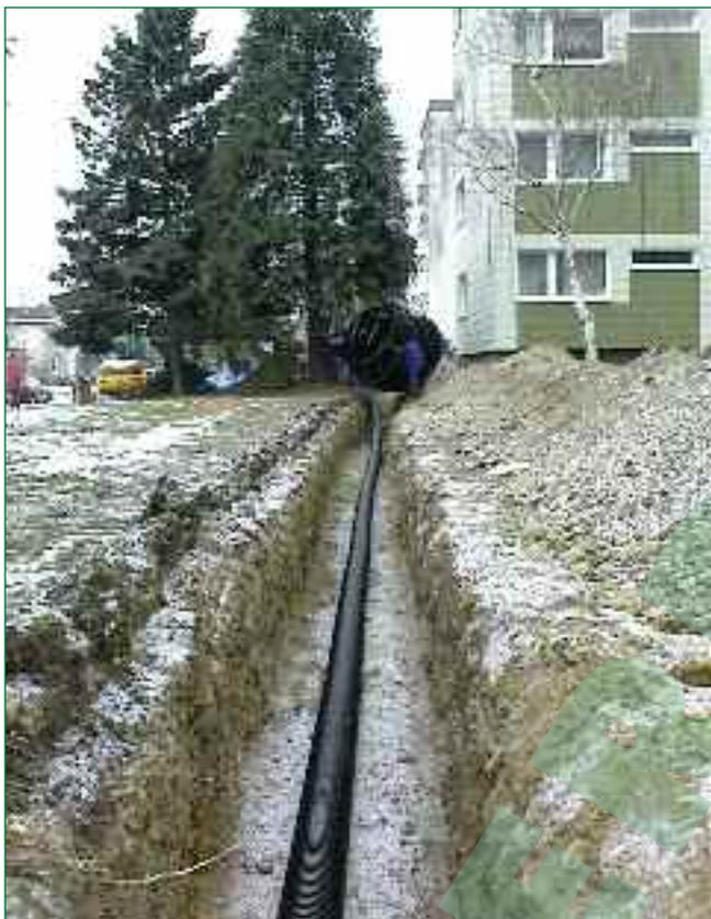
*Bild 3: Auch bei winterlichem Wetter problemlos verarbeitet und sauber durch den Trassengraben geführt: das vorgedämmte PE-X-Rohr von Uponor Ecoflex*
