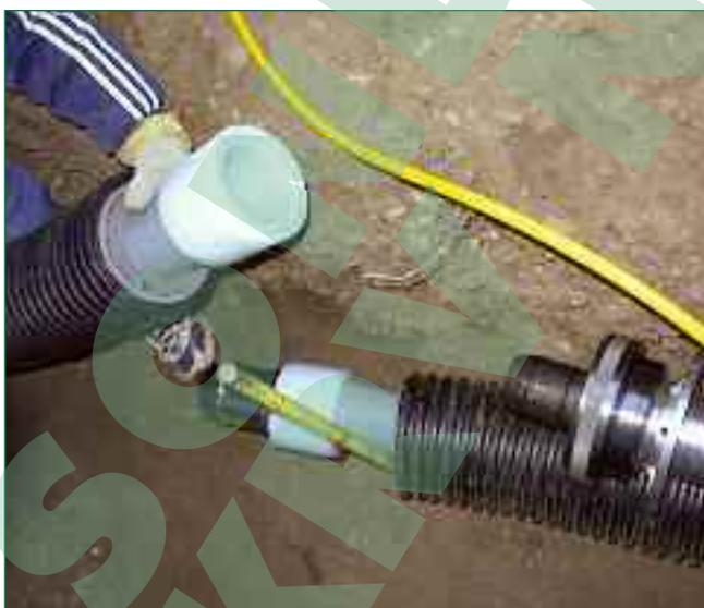
*Bild 6: Fertig zum Verpressen: das mediumführende PE-X-Rohr mit dem Sicherungsring*
