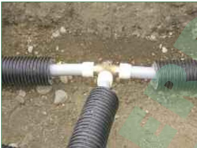
*Bild 5: Mit einem T-Stück ausgeführte Quick&Easy-Verbindung – sauber auf der Baustelle ausgeführt*
