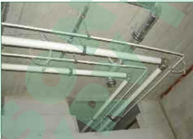
Bild 2: Markanter Bestandteil der Energieverteilung im Solar Info Center Freiburg: 10 Kilometer Mehrschichtverbundrohre und 16.000 Fittinge
