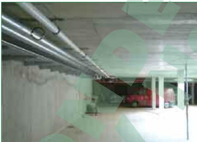
Bild 4: Mehrschichtverbundrohre mit  $d = 110$  mm als Zuleitung in der Tiefgarage des Solar Info Centers Freiburg
