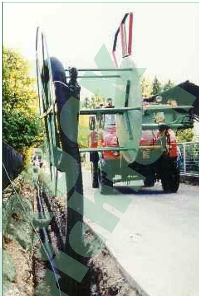
*Bild 5: Verlegung der Fernwärmerohre für das Biomasseprojekt in Nötsch*
