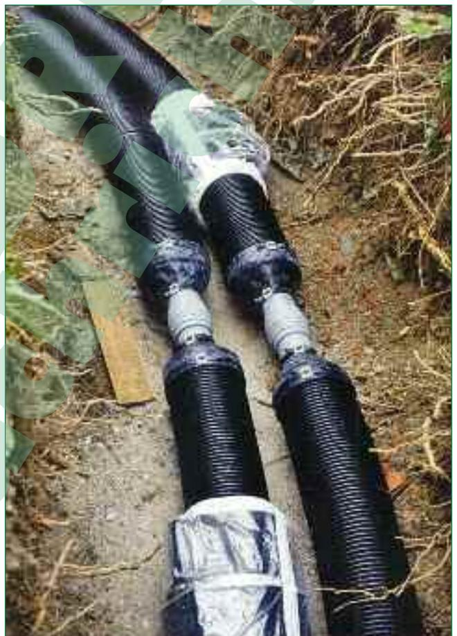
*Bild 1: Fernwärmerohre aus Polybuten*
