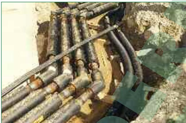
Bild 3: Das Foto macht die Vorteile flexibler Polybutenrohre deutlich: PB-Rohre sind schneller und leichter verlegt und benötigen weit weniger Verbindungsstellen als Stahlrohre
