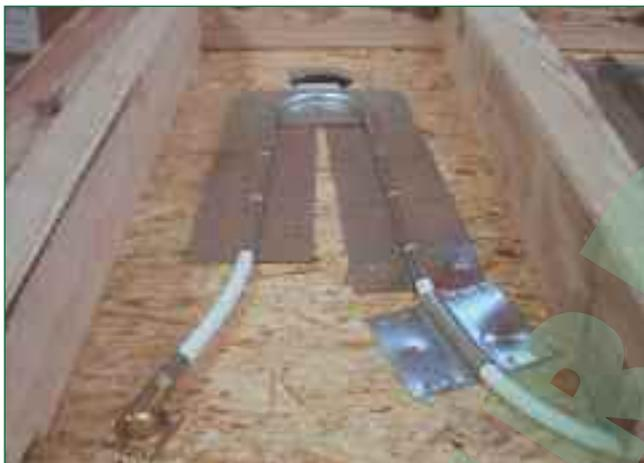
*Bild 4: Die Polytherm-Wandtemperierung, die den Wärmeübergang von den Räumen in die Außenwände verhindert, wurde mit MT-Verbundrohren verlegt. Durch ihre in Kunststoff eingebettete Aluminiumschicht sind sie bei Bedarf problemlos und sicher zu orten (Foto: H. G. Stumpf)*
