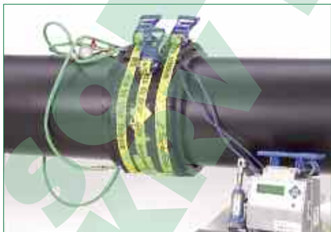
Bild 3: Großrohrmuffe mit Druckkissen-set beim Schweißvorgang
