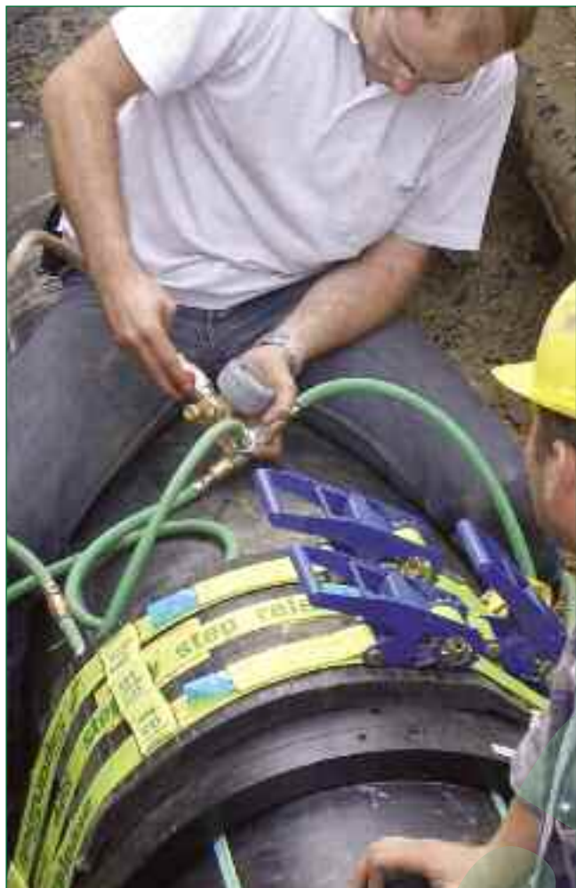
Bild 2: Fixieren der Großrohrmuffen mittels Druckluftkissen und Spannkorsett. Beaufschlagen des Kissens mit Luftdruck
