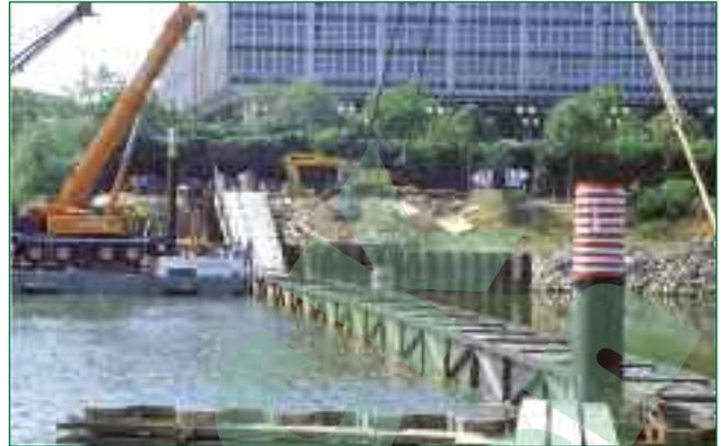
Bild 6: Einschwimmen nach kurzer Montagezeit – Neckardüker beim Absenken
