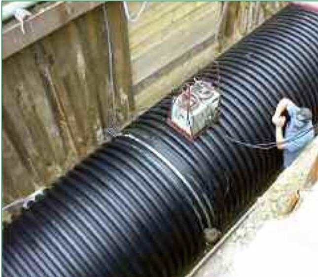
Bild 5: Zugfeste Rohrverbindung – Herstellung einer Schweißverbindung bei PKS-Rohren
