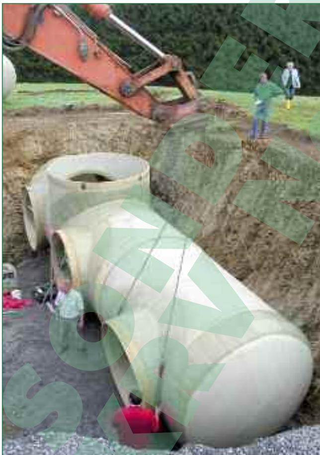
*Bild 1: Erster Arbeitsschritt: Die Pumpenkammer wird gesetzt*
