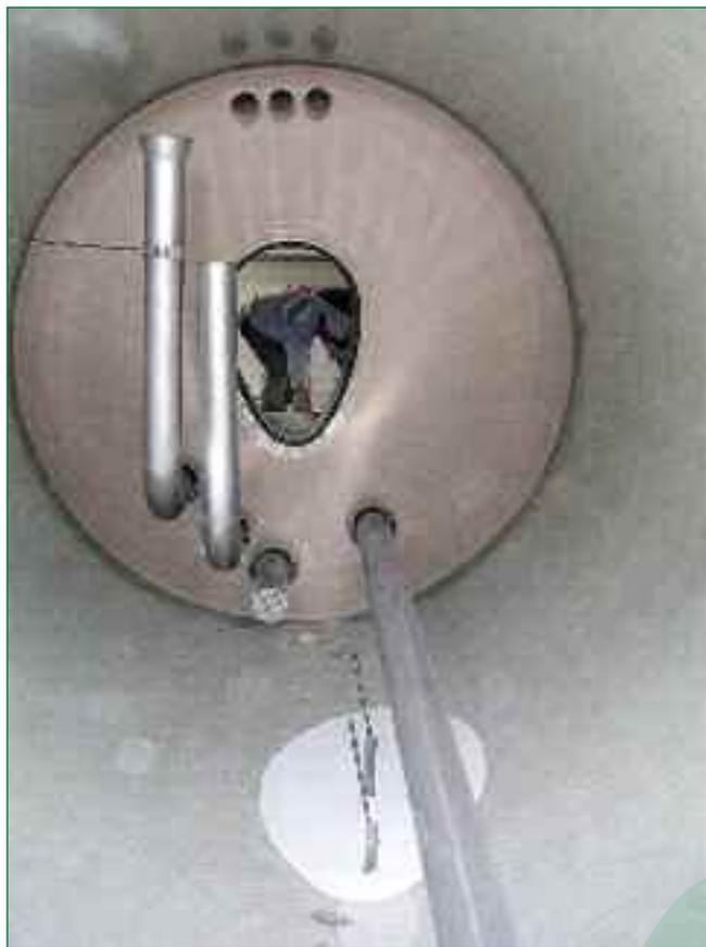
Bild 4: Abschluss eines Speichersegments zur Pumpenkammer mit Rohrinstallationen
