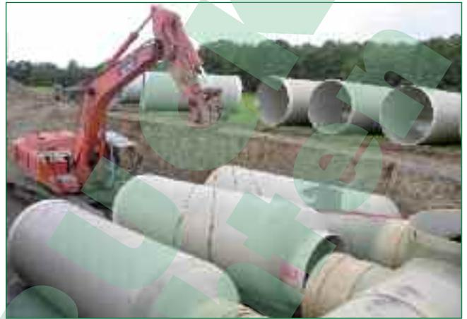
*Bild 2: Trinkwasserspeicher im Baukasten-System. Ankoppeln eines Flowtite-Speicherelements DN 2400 an die Pumpenkammer*
