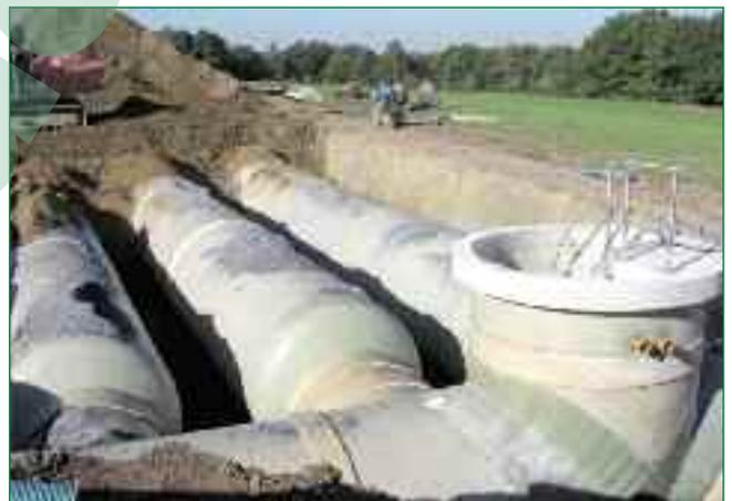
*Bild 3: In nur einer Woche Bauzeit wurden die GFK-Elemente des neuen, 280 Kubikmeter fassenden Trinkwasserspeichers Etzbach installiert*
