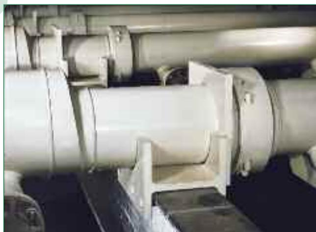
*Bild 9: U-Profilträger aus PP-H wurden speziell für die Aufnahme der Rohre gefertigt, um die axiale Beweglichkeit der Rohre zu gewährleisten*
