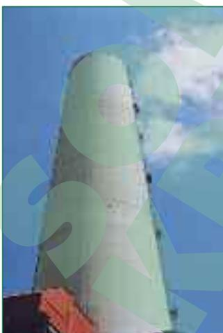
Bild 12: Abgaskamin der gereinigten Abluft; die roten Kanäle besitzen einen Durchmesser von 7 m und leiten das Reingas in den Kamin
