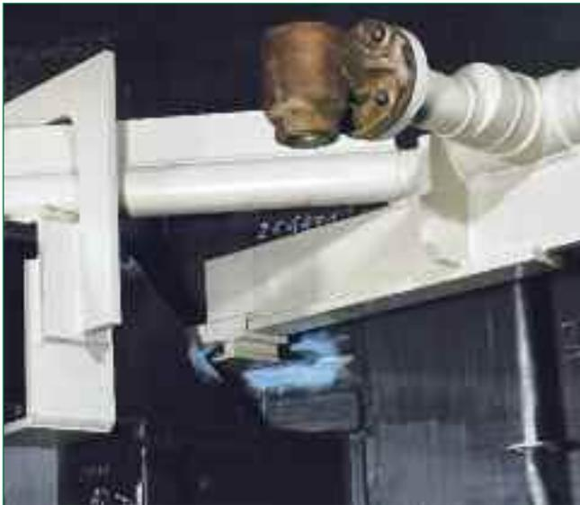
Bild 10: Schiebelager am Ende der Düsenlanze zur Aufnahme der thermischen Dehnung
