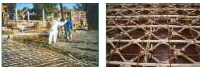
Bild 4: Betonkernaktivierung (links) und oberflächennah angeordnete Kunststoffrohre in der Decke zum Kühlen und Heizen
