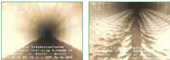
Bild 5: Vergleich der Aufnahmen am 16.12.2004 (Sedimenthöhe ca. 100 mm) und 05.09.2005 (Sedimenthöhe ca. 3 mm) am Kamerastandort 37,3 m [6, 7]
