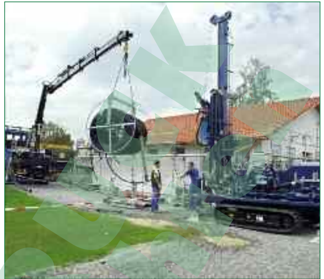
Bild 3: Einbau der Erdwärmesonde
