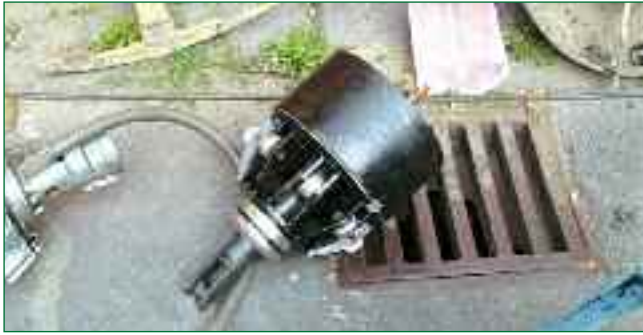
Bild 5: Nach Einschub des Gestänges wird ein sogenannter Rollenführungskopf an das Gestänge angekoppelt; dieser dem Neurohr vorgeschaltete Rollenführungskopf aus Stahl beseitigt mögliche Deformierungen in der alten Leitung und ebnet somit den neuen Rohren den Weg
