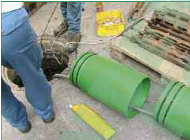
Bild 7: Rohrmodule zum Einbau bereit
