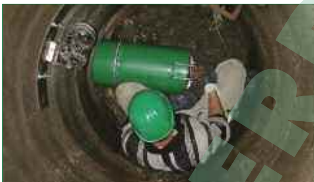
Bild 10: Verbinden und Einbau der PP-HM Rohre im vorhandenen Abwasserschacht
