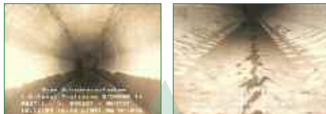
Bild 6: Vergleich der Aufnahmen am 16.12.2004 (Sedimenthöhe ca. 76 mm) und 05.09.2005 (Sedimenthöhe ca. 2 mm) am Kamerastandort 81,6 m [6, 7]
