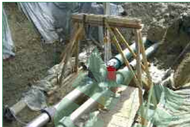
Bild 12: Ankopplung an das bestehende Netz
