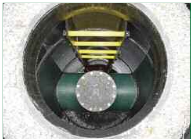
Bild 9: Mit der Schachtwand verschmolzene Steigangelemente
