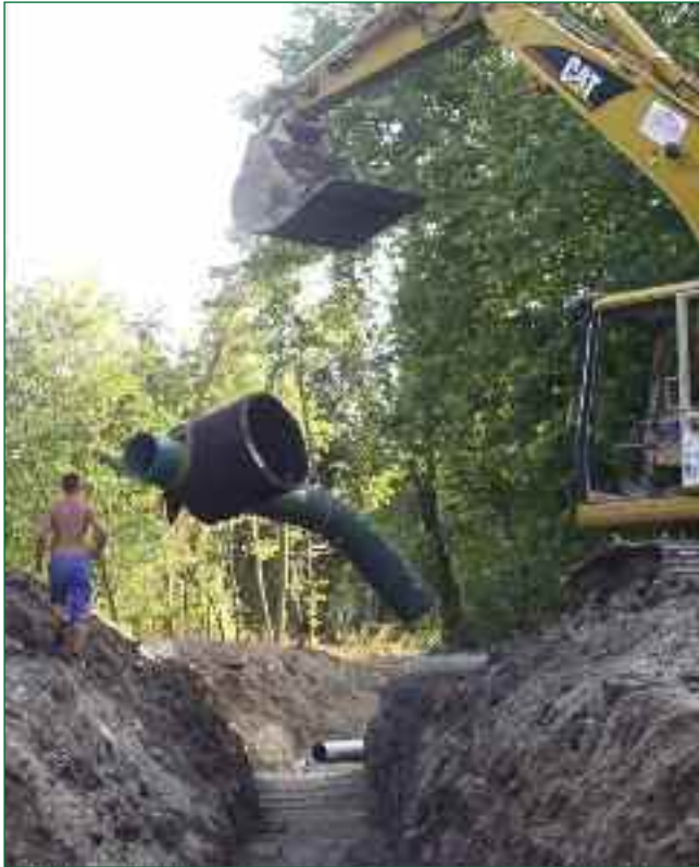
Bild 5: Einbau der Schächte an den Richtungsänderungen der Trasse
