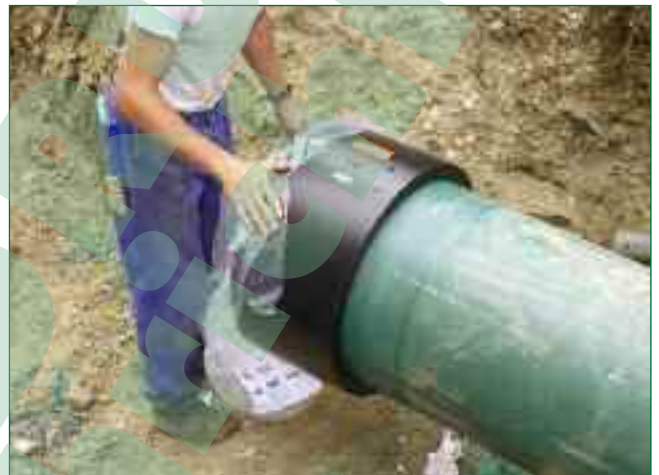
Bild 8: Schächte und Rohre wurden mittels Elektroschweißmuffen verbunden
