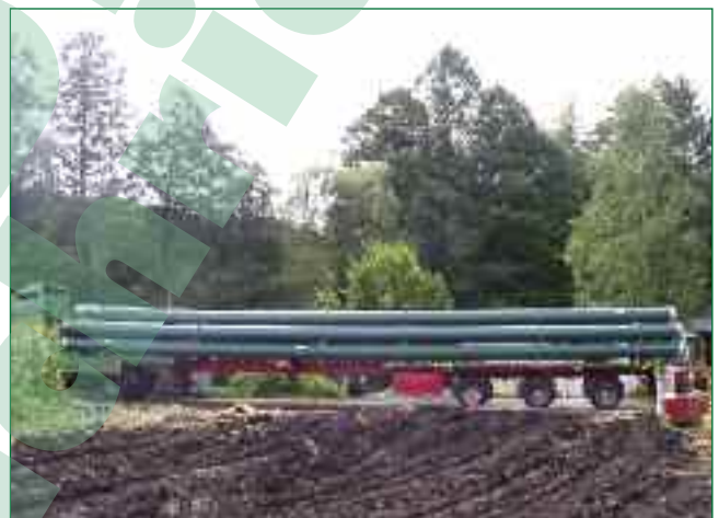
Bild 2: Anlieferung der Rohrstangen
