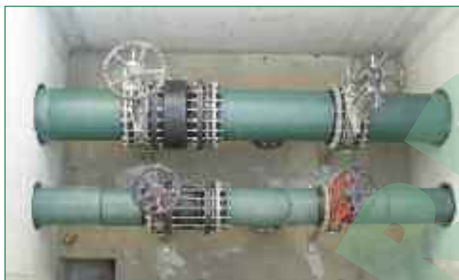
Bild 10: Revisionschacht mit Ansperrschiebern
