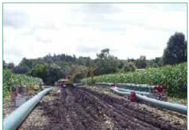
Bild 3: Auslegen und Verschweißen der Rohrstangen
