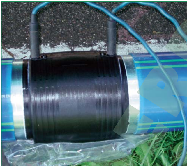
Bild 5: Sichere Verbindungstechnik durch Verschweißung von Rohrenden
