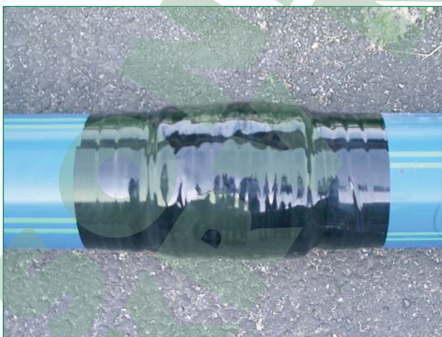
Bild 6: Durch nachträgliche Umhüllung wird der Diffusionsschutz wiederhergestellt.
