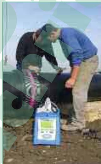
Bild 4: PE-Rohr, Verbindungstechnik: Heizwendelschweißen Muffe und Schweißgerät
