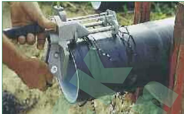
Bild 6: Vorbereitung der Fügeflächen, Schälen der Rohroberfläche zur Entfernung der Oxidhaut
