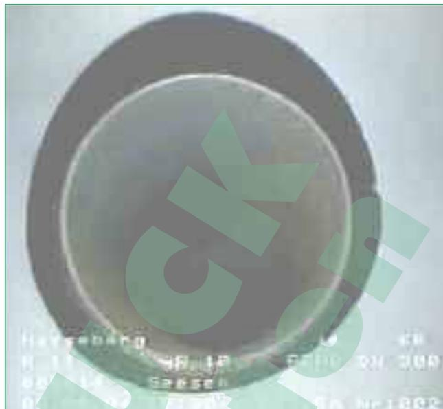
Bild 11: Kanalinspektion mittels Kamerabefahrung: Einblick in den ASA-Hausanschluss
