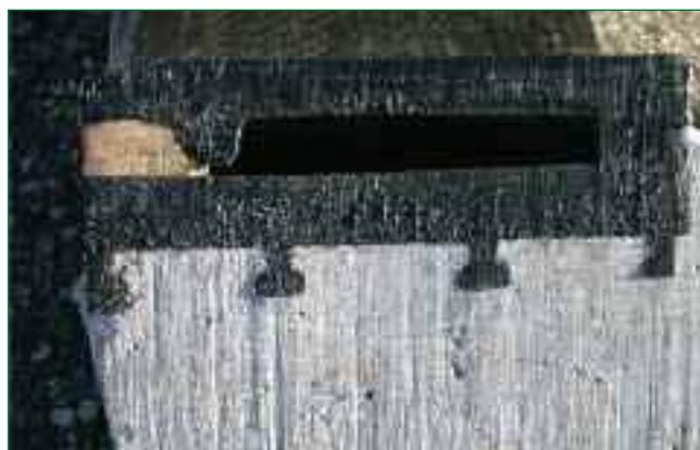
Bild 9b: Schnittstelle ASF-Schachtfutter/Beton. Das Bild zeigt die Verkragung der T-Stege am Futter im Betonschacht und die elastomere Zwischenschicht, die die Flexibilität der Schnittstelle gewährleistet
